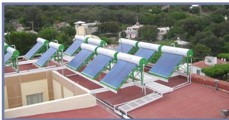
Figura 9.2 Termotanques Solares Instalados sobre Viviendas.
