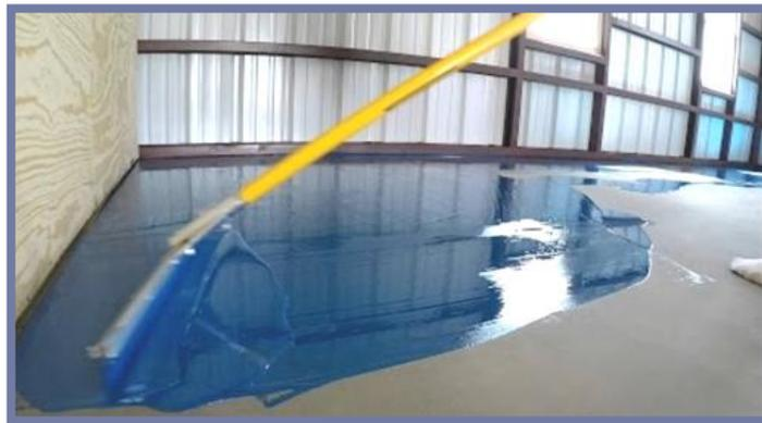
Figura 10.5 Pintura Epoxi para Pisos.
