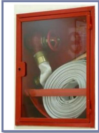
Figura 10.55 Nicho de Agua, Hidrante y Manguera
