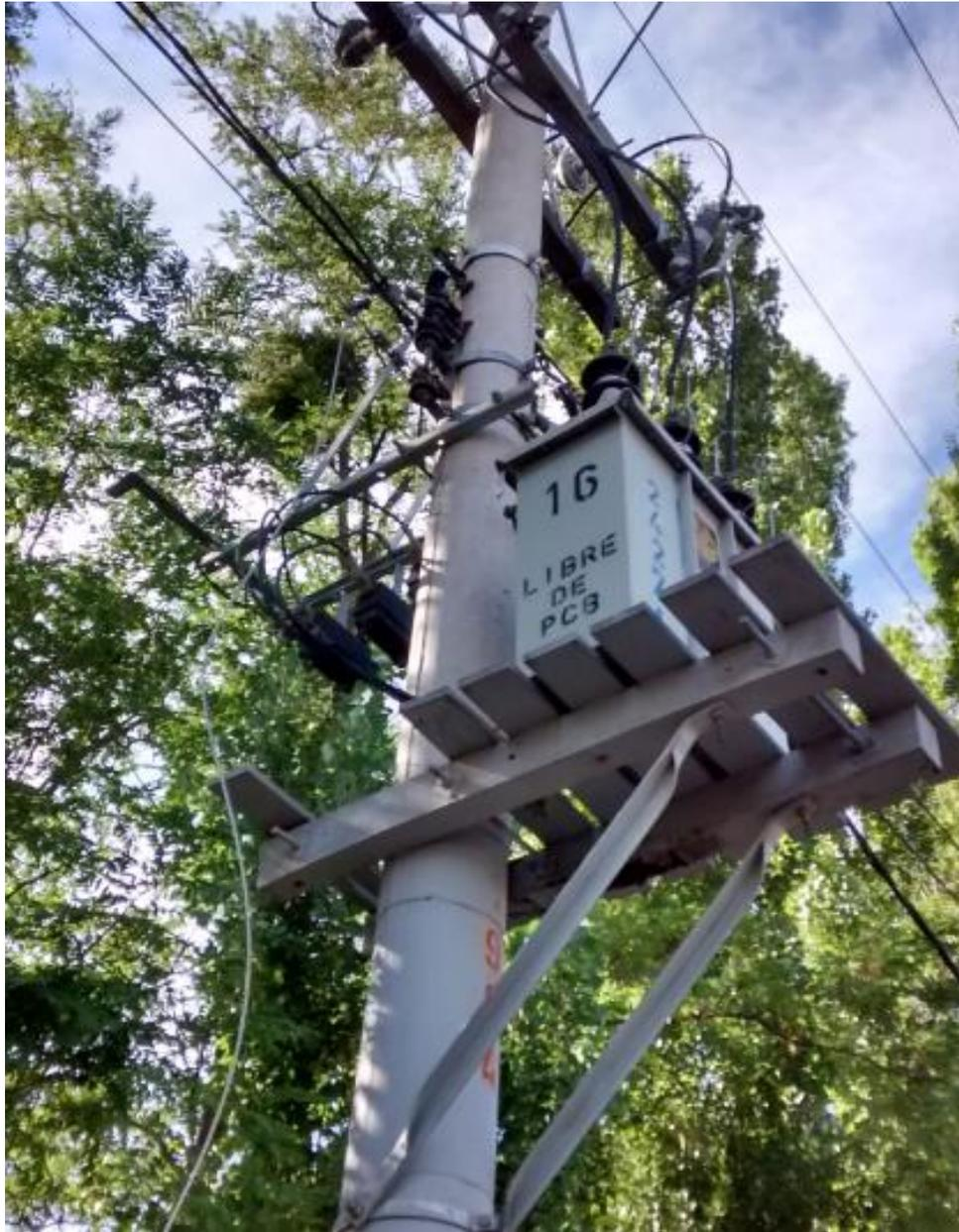
*Imagen 15 Trafo a reemplazar*
