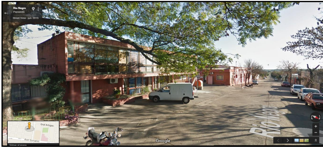
Figura N°88-Calle Rio Negro (al norte)-Ubicación Oficinas del Departamento General de Servicios
