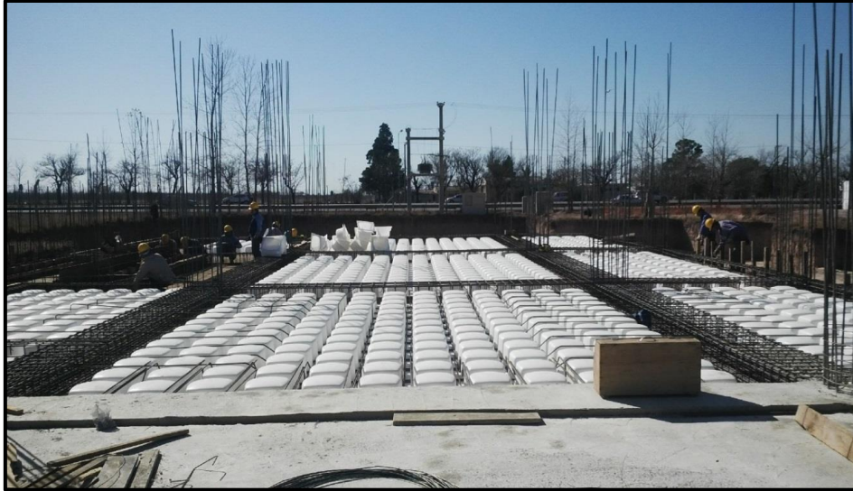
Figura N°99- Losa Casetonadas
