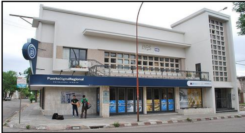
Figura N°76 - Centro MEC de Paysandú
