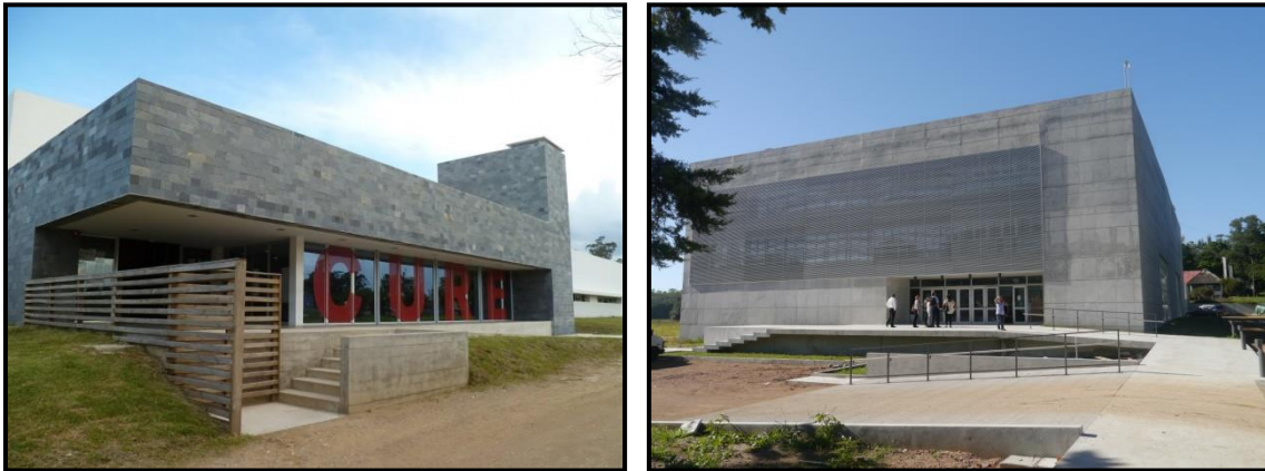
Figura N° 62- Centro Universitario de Rocha (Izquierda)- Centro Universitario de Maldonado (Derecha)
