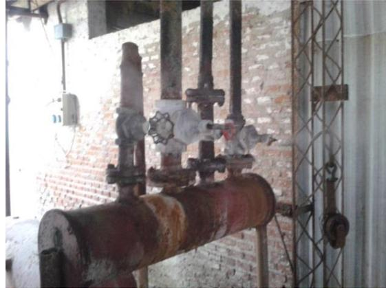
Caldera, distribuidor de vapor y cañerías con mucho óxido sin mantenimiento según Dec. 351/79 Cap. 16 Art 140 y Ley 19587 Art. 9 b).
