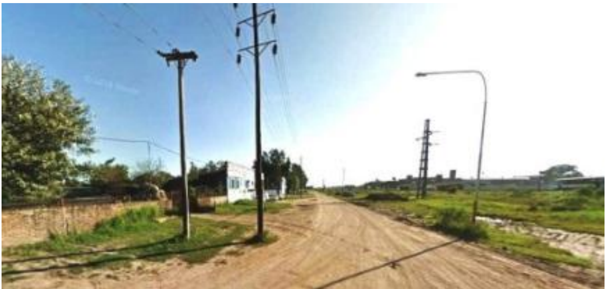
Imagen N°9: Jirafas de Iluminación Fuente: Street View– Fotografía panorámica
