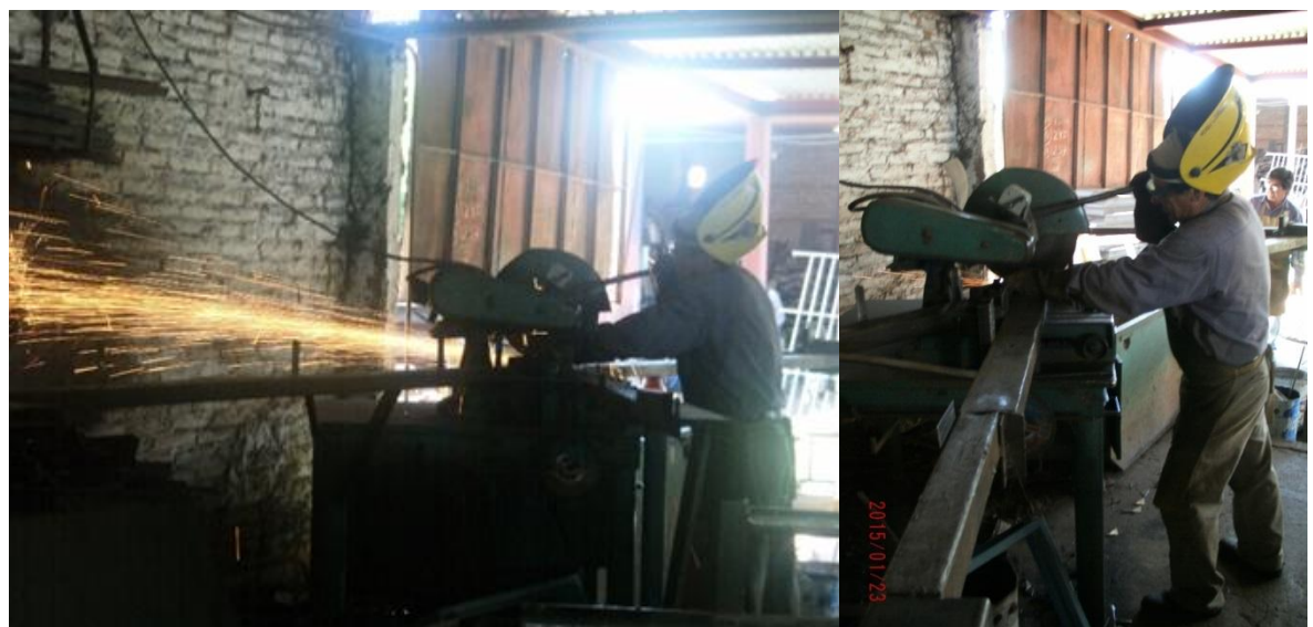
Imagen N°93: Uso de la sierra sensitiva Fuente: Elaboración propia – Fotografía tomada in situ
