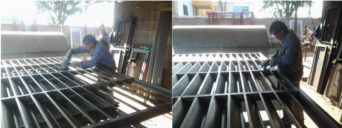
Imagen N°32: Pulido de cordones de soldadura Fuente: Elaboración propia – Fotografía tomada in situ
