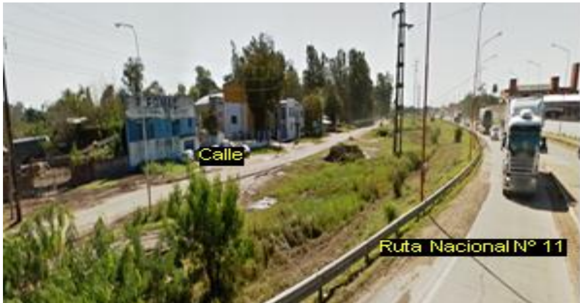
Imagen N°7: Ruta Nacional N° 11 Fuente: Street View– Fotografía panorámica
