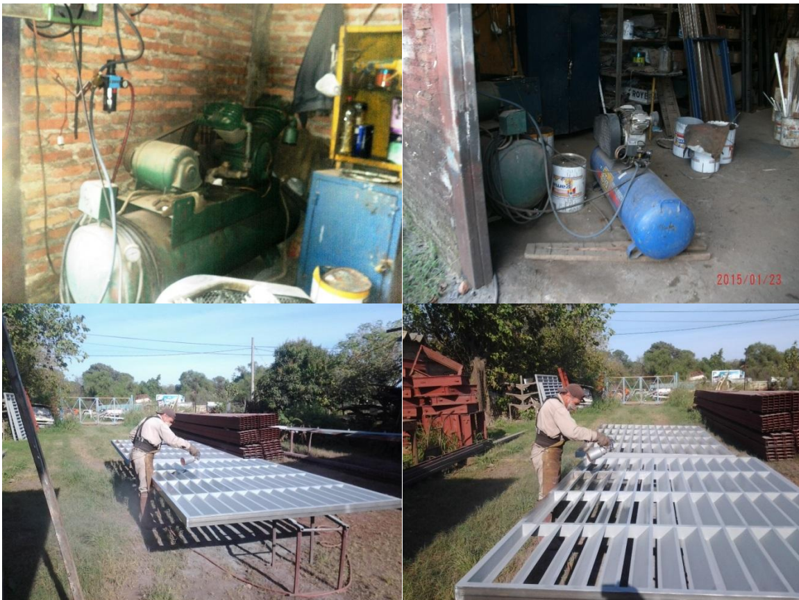
Imagen N°33: Equipamiento y Trabajos de Pintura Fuente: Elaboración propia – Fotografía tomada in situ
