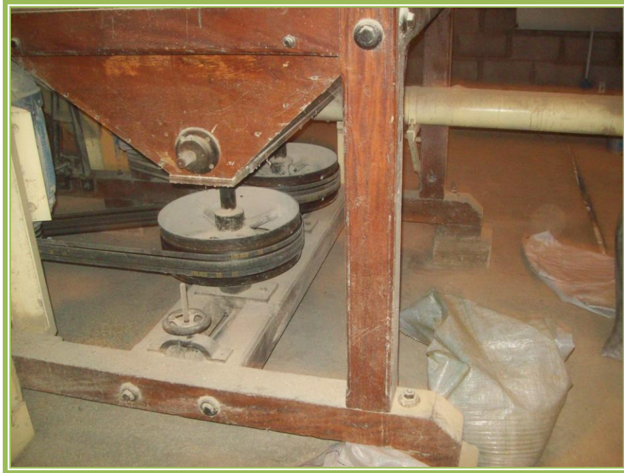
Gráfico N°59: Riesgo Mecánico: Poleas sin resguardo
