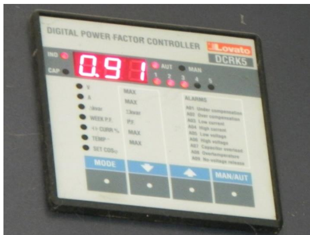
Fotografía 3.1 – Regulador de factor de potencia – Elaboración propia.
