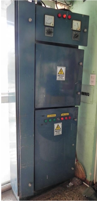
Fotografía 6.1 – Tablero principal 1 – Elaboración propia
