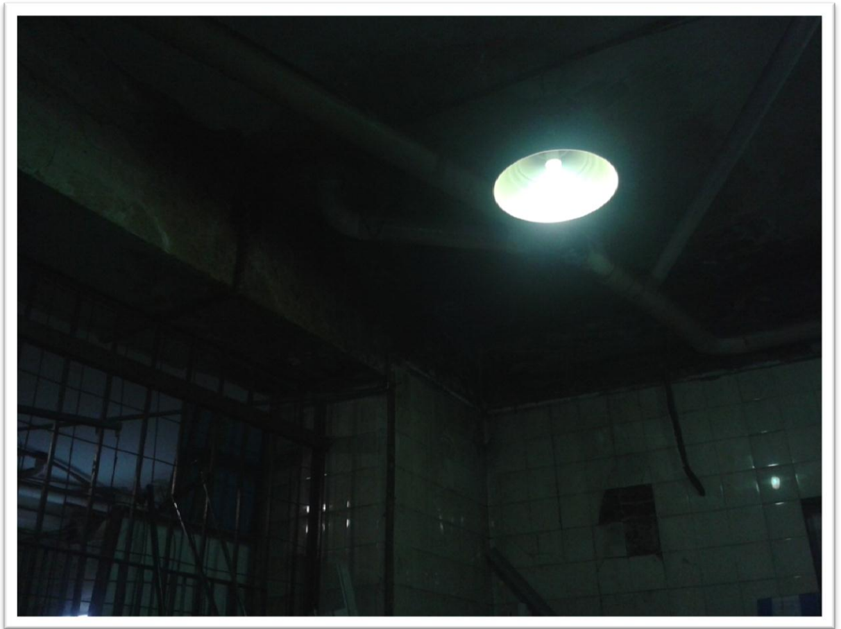
Imagen N°61: Iluminación en taller de herrería.
