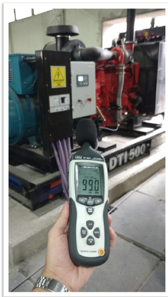
Imagen N°62: Medición de ruido en sala de máquinas.
