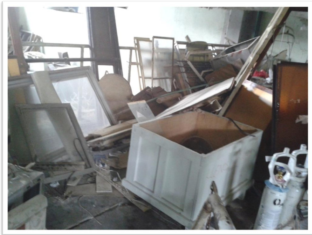
Imagen N°56: Almacenamiento de gases medicinales en sala de máquinas.
