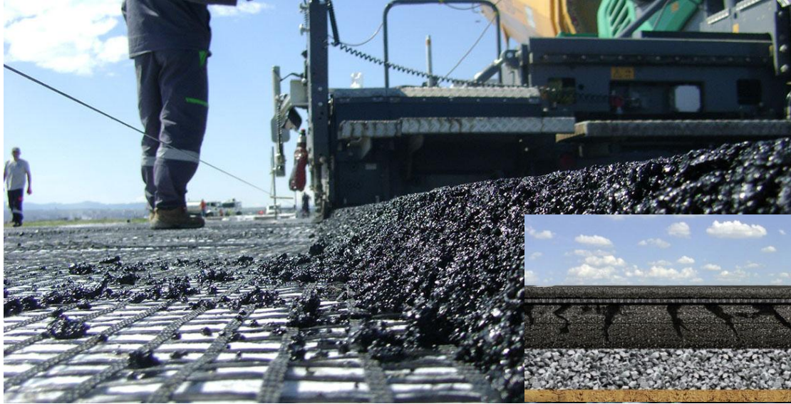
Figura 7 Geomalla en carpeta asfáltica
