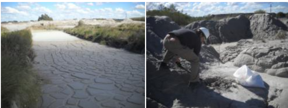
Fotografía 2: Secado de filler y de área de depósito
