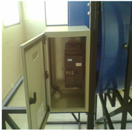
Figura 6:A) Fotografía del variador de frecuencias B) Tablero de comandos
