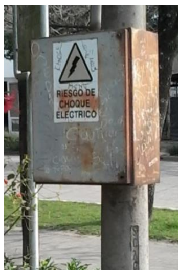
Figura 1.14- Tablero de iluminación
