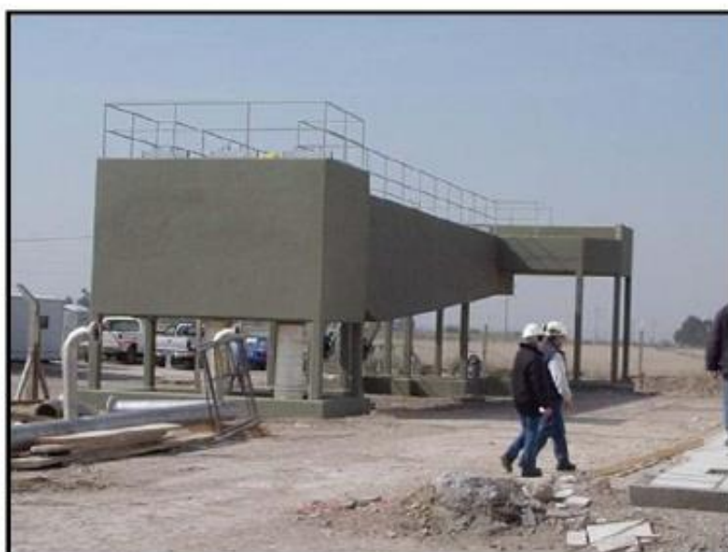
Figura 9 – Vista de un desarenador
