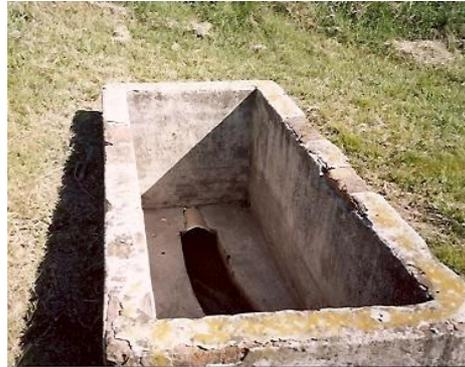
*Figura N° 19. Cámara de aforo*
