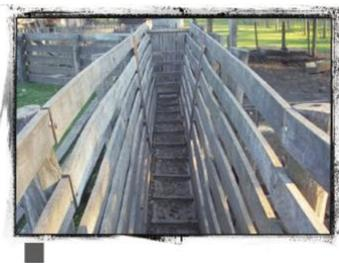
Manga con detalle de tacos en el piso para evitar el deslizamiento de los animales.
