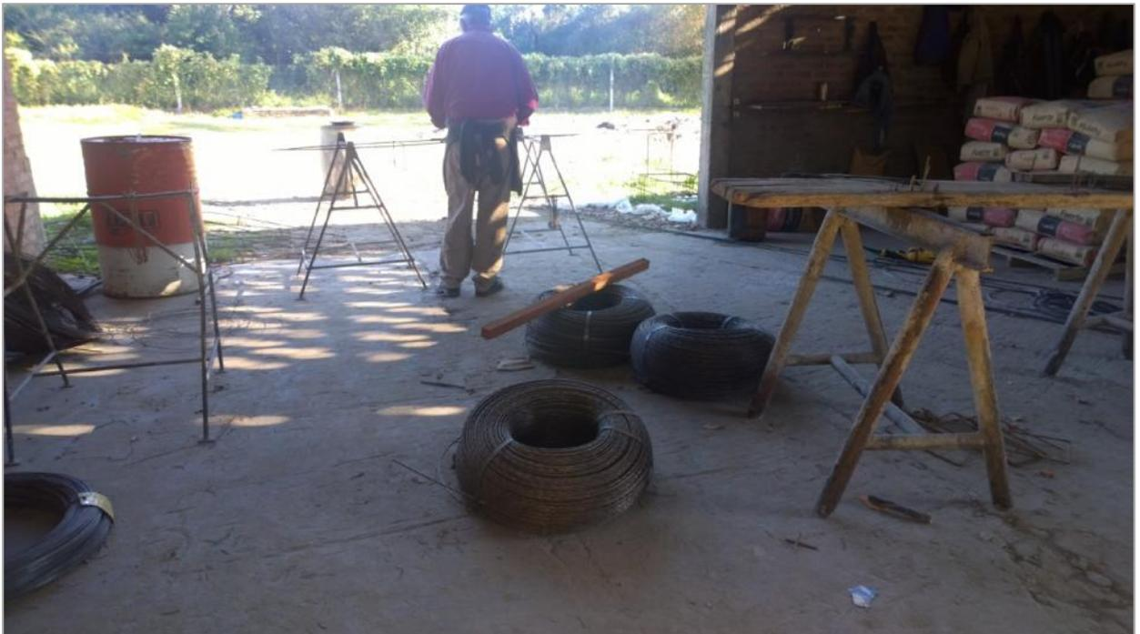
Las armaduras se amarran con alambre, a excepción de las barras de puesta a tierra, que junto con los bloquetes, son soldados a la armadura. El material necesario para conformar las armaduras, es acopiado en el mismo lugar.
