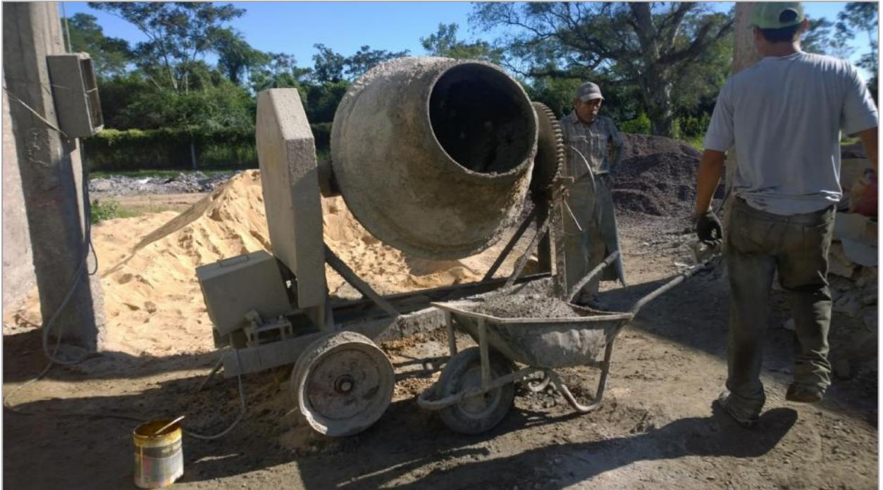
El cemento es traído “a hombro” desde la zona de acopio de este material distante a unos cinco metros. El hormigón fresco es vertido en carretillas con las cuales se transporta hasta los moldes.
