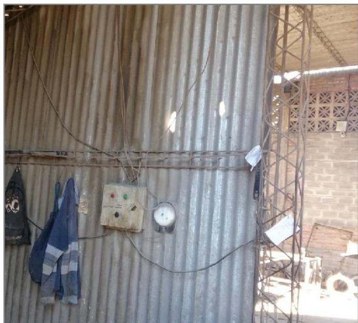
Equipos de maniobra y protección salidos de sus rieles o sin cajas protectoras y con conexiones defectuosas o haciendo mal contacto.
