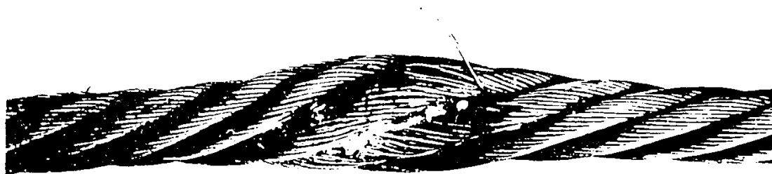
Fig. 18.— Aplastamiento debido a una acción mecánica que provoca el aplastamiento del cable. El cable debe ser retirado.
