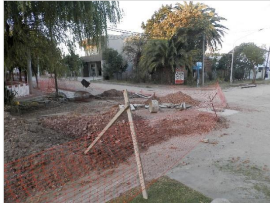
Figura 1.31| Construcción desagües Cuenca Malvinas
