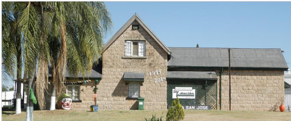
Figura 1.34| Estación de Ferrocarril de la Ciudad de San José
