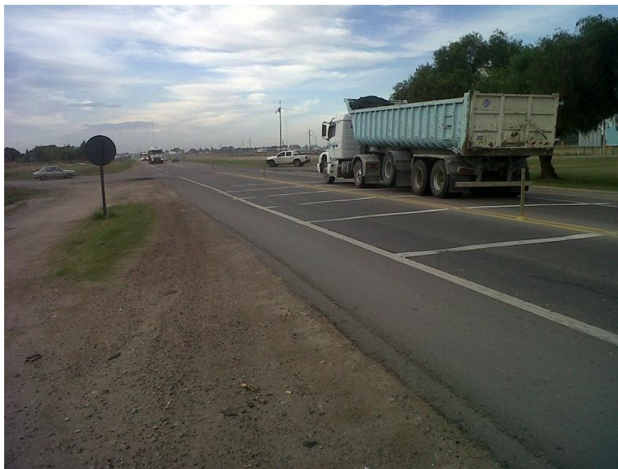
Imagen AI.2: Ausencia de rotonda en el cruce con calle Charlone y acceso a Balneario Maldonado (Vulnerabilidad Económica).
