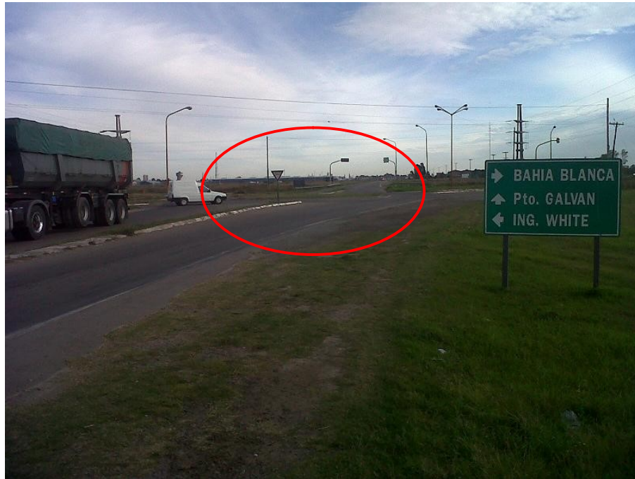
Imagen AI.8: Rotonda pequeña, con escasa señalización y ausencia de guard raid (Vulnerabilidad Técnica).
