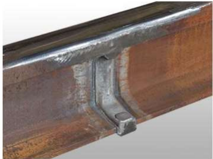
Figura Nº 209. Soldadura aluminotérmica. Fuente: Railtech.
