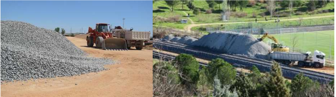
Figura Nº 261. Imágenes de balasto y su colocación. Fuente: Blog Crónica Ferroviaria
