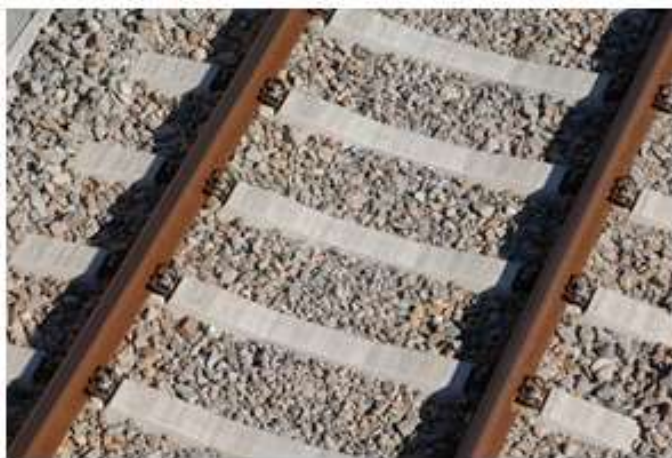
Figura Nº 202. Fijaciones Vossloh W21 SK 21. Fuente:
