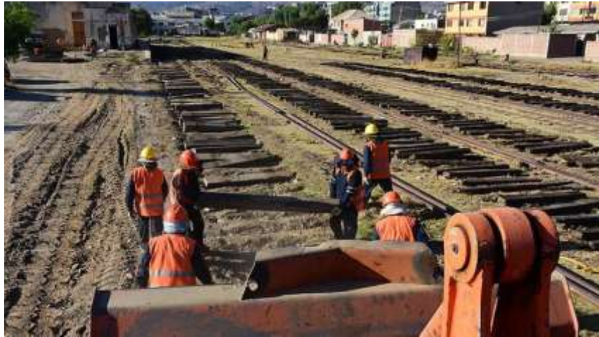
Figura Nº 257. Imagen de trabajos de recuperación de material ferroviario. Fuente: Blog Crónica Ferroviaria
