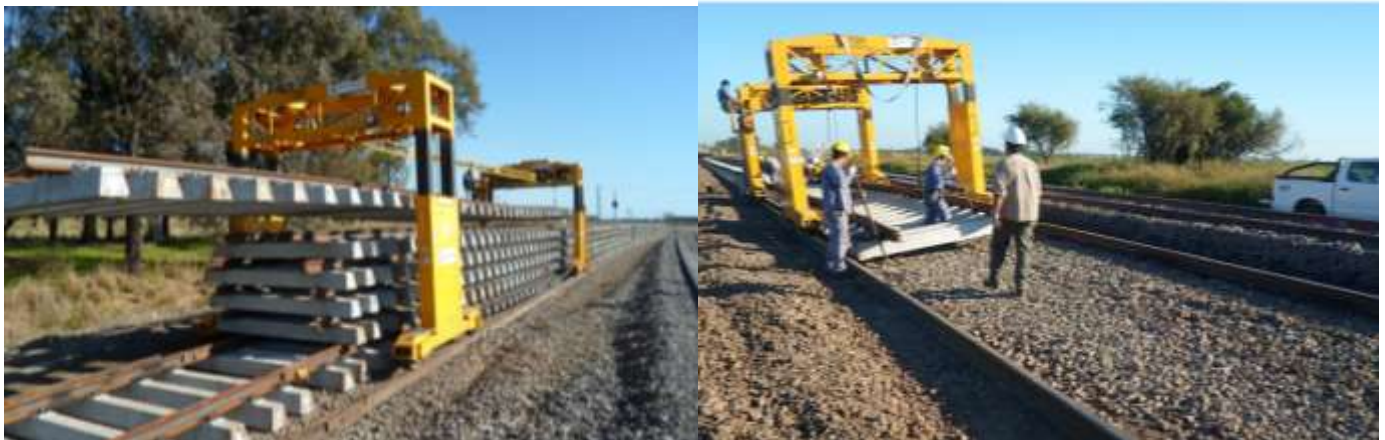
Figura Nº 262. Imágenes de colocación de durmientes. Fuente: Blog Crónica Ferroviaria
