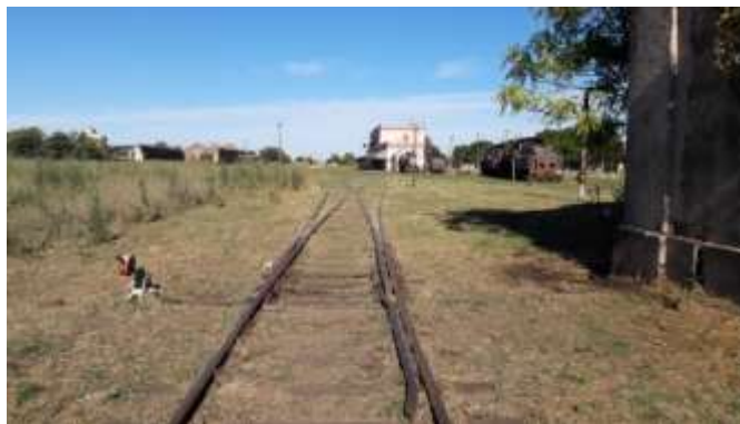
Figura Nº 132. Vía en la zona de la Estación. Fuente: Elaboración propia.
