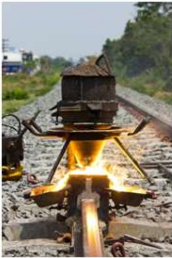
Figura Nº 209. Soldadura aluminotérmica. Fuente: Railtech.
