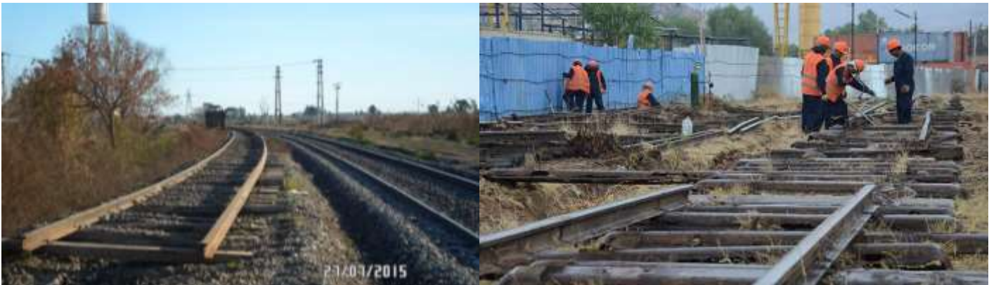
Figura Nº 256. Imágenes de trabajos de desarme y retiro de vía. Fuente: Blog Crónica Ferroviaria
