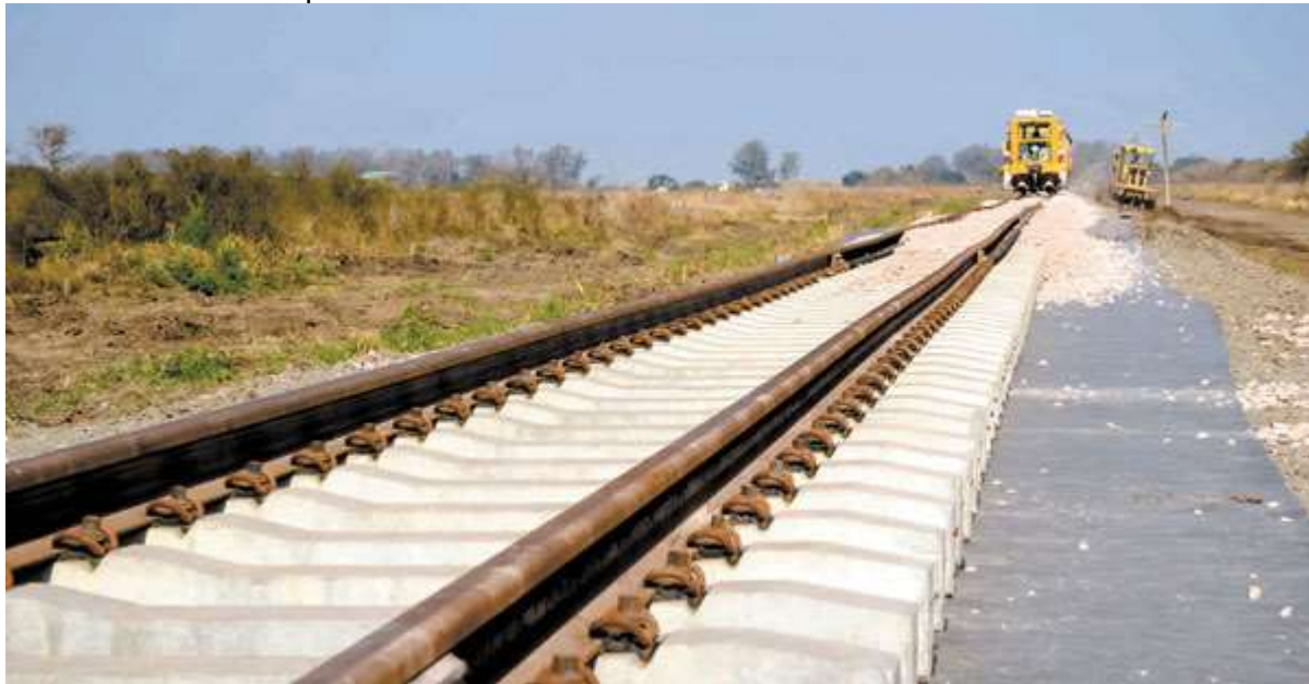
Figura N° 260. Imagen de colocación de geotextil. Fuente: Blog Crónica Ferroviaria
