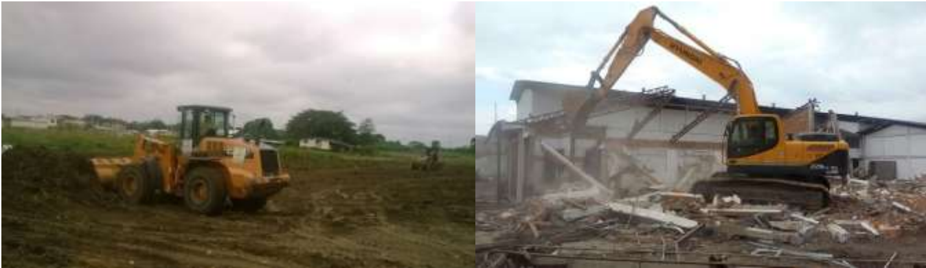
Figura Nº 255. Imágenes de limpieza y demolición. Fuente: Blog Crónica Ferroviaria
