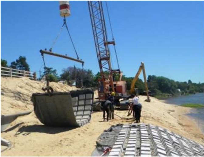
Figura N° 242. Protección con dados de hormigón prefabricados. Fuente: D.H.E.R.
