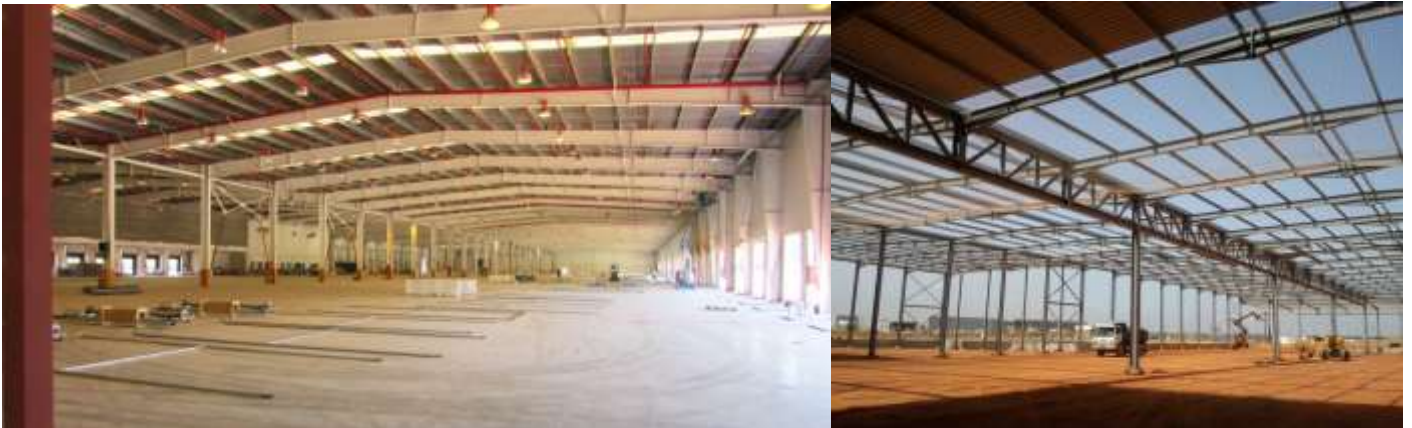
Figura Nº 274. Imágenes de Nave industrial. Fuente: Blog de Crónica Ferroviaria.
