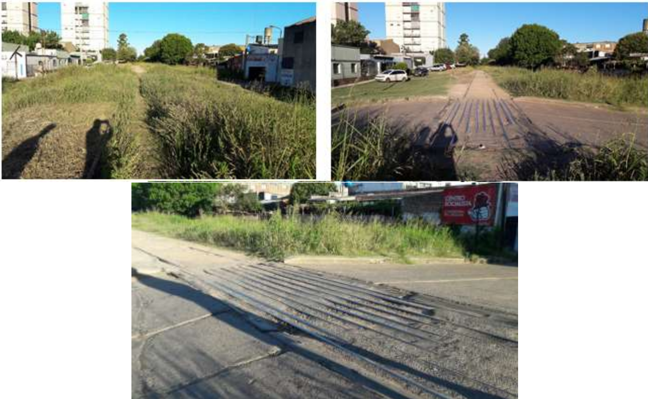
Figura Nº 173. Imágenes de PaN pavimentados con pendientes pronunciadas. Fuente: Elaboración propia
