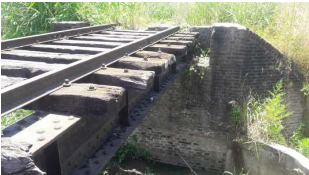
Figura Nº 146. Imágenes de puente y estribo. Fuente: Elaboración propia.
