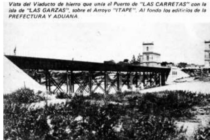
Figura Nº 75. Viaducto que unía el Puerto de "Las Carretas" con la isla de "Las Garzas". Fuente: Histarmar
