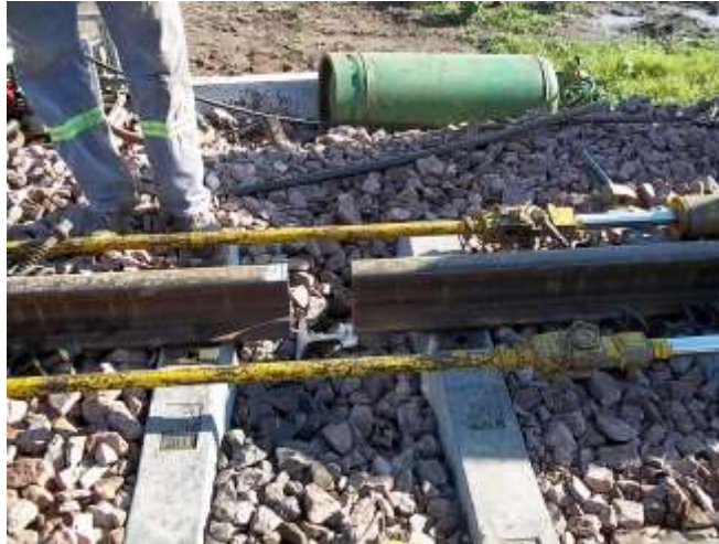
Figura N° 2663. Imagen del proceso de liberación de tensiones. Fuente: Blog Crónica Ferroviaria
