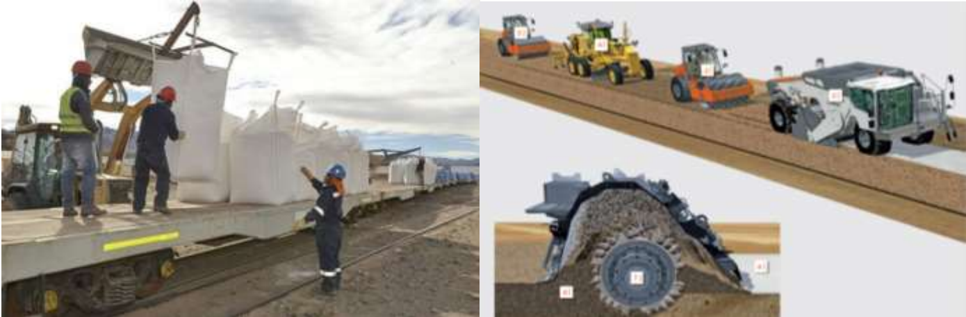
Figura N° 259. Imágenes de trabajos para mejorado con cal. Fuente: Blog Crónica Ferroviaria
