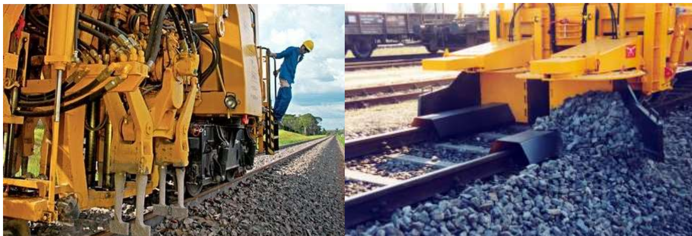
Figura Nº 264. Imágenes de trabajos de la ripadora. Fuente: Blog Crónica Ferroviaria
