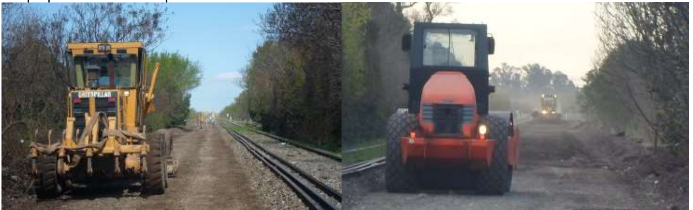
Figura Nº 258. Imágenes de conformación de plano de formación. Fuente: Blog Crónica Ferroviaria
