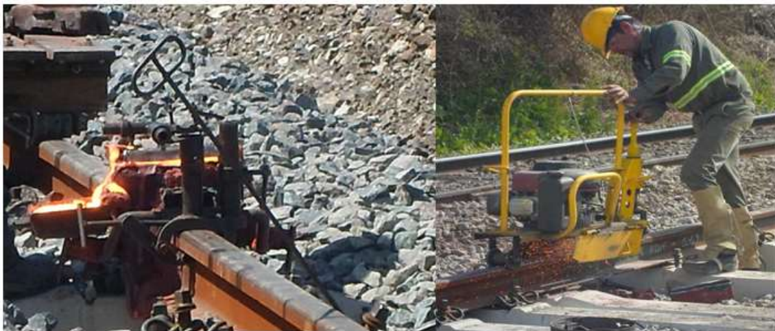
Figura N° 2652. Imágenes de trabajos de soldadura de rieles. Fuente: Blog Crónica Ferroviaria
