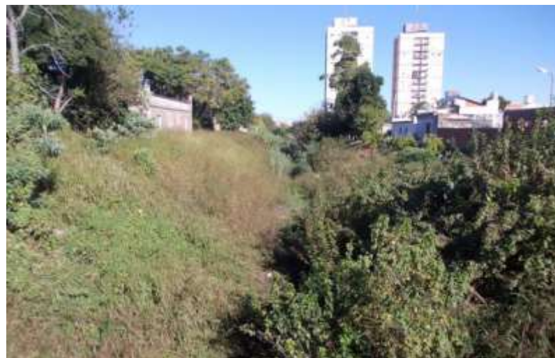
Figura Nº 130. Vía en desmonte. Fuente: Elaboración propia.
