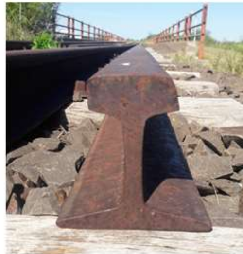
Figura Nº 135. Geometría del riel. Fuente: CNRT
