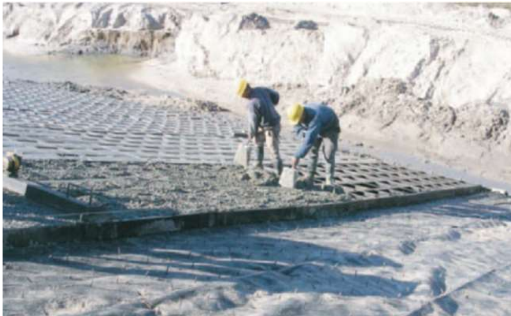
Figura N° 243. Protección con dados de hormigón in-situ. Fuente: D.H.E.R.
