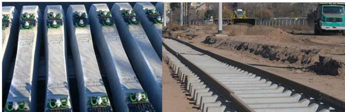
Figura Nº 204. Durmientes monoblock hormigón pretensado. Fuente: Premoldeados de Argentina.
