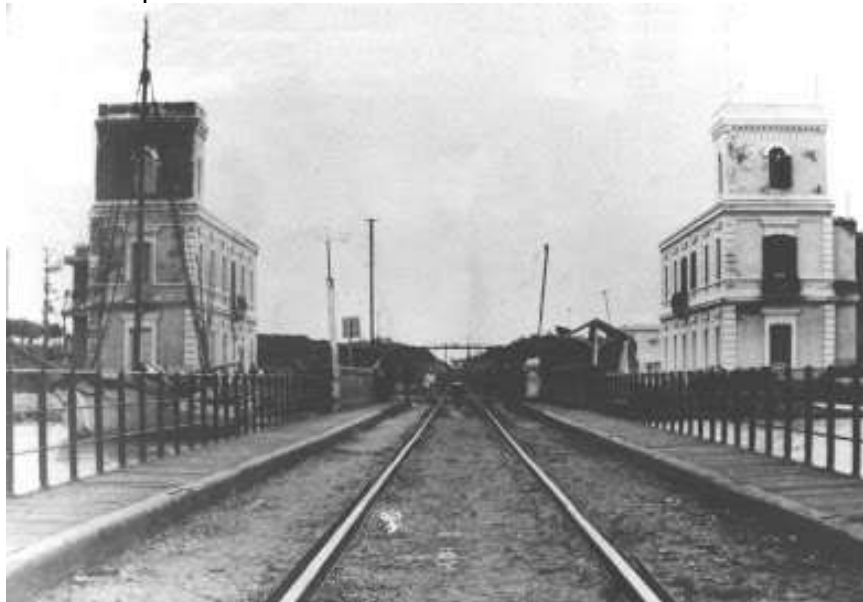
Figura Nº 76. Vías históricas de acceso al Puerto. Fuente: Histarmar
