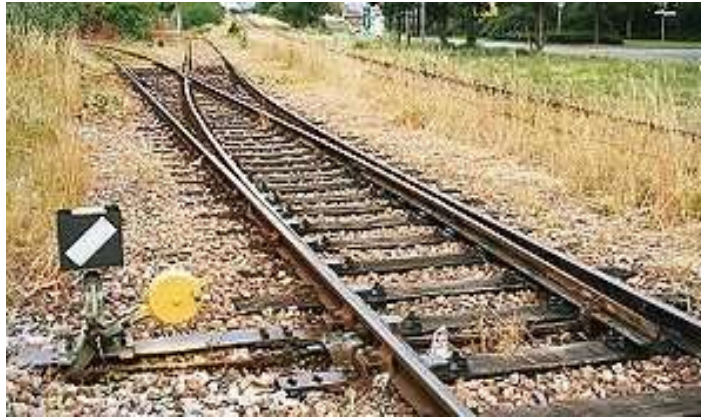
Figura Nº 273. Imagen de desvío ferroviario. Fuente: Blog de Crónica Ferroviaria.
