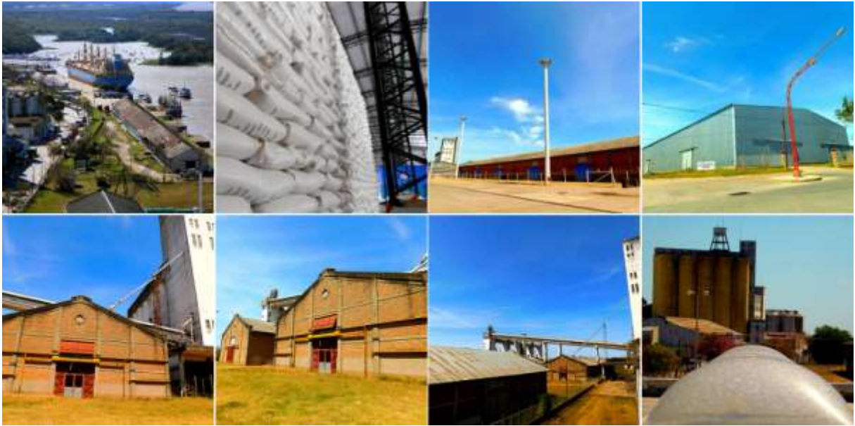
Figura Nº 86. Galpones de almacenamiento del Puerto de Concepción del Uruguay. Fuente: Página oficial
