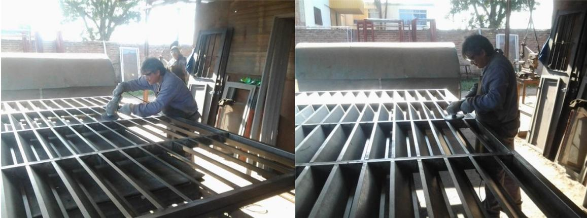
Imagen N°32: Pulido de cordones de soldadura
