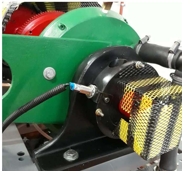
Fig. 5.25: Sensor inductivo instalado, vista lateral.
