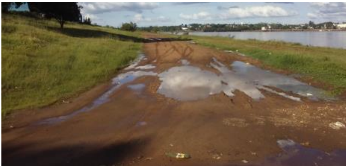
Figura 5 - Playa Nébel - Progresiva 0280 (fotografía de N a S)
