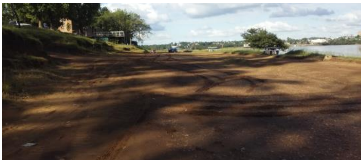
Figura 2 - Progresiva 0130 (fotografía tomada de S a N)
