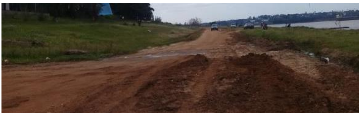
Figura 11 - Playa Nébel - Progresiva 0230 (fotografía tomada de S a N)
