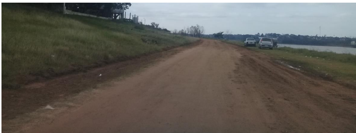
Figura 12 - Playa Nébel - Progresiva 0330 (fotografía tomada de S a N)
