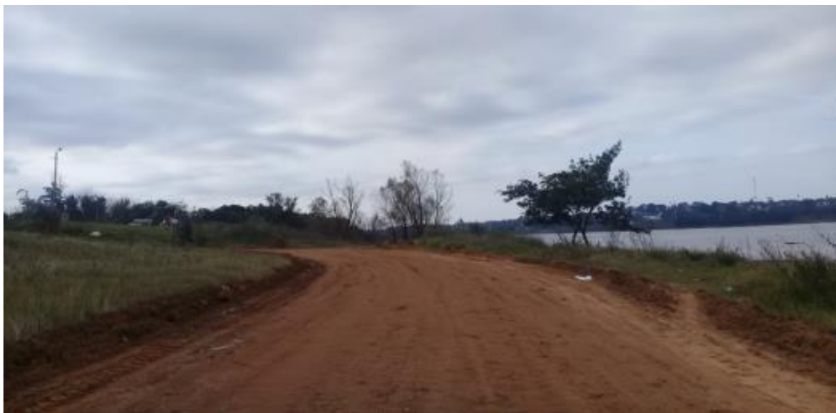
Figura 13 - Playa Nébel - Progresiva 0400 (fotografía tomada de S a N)
