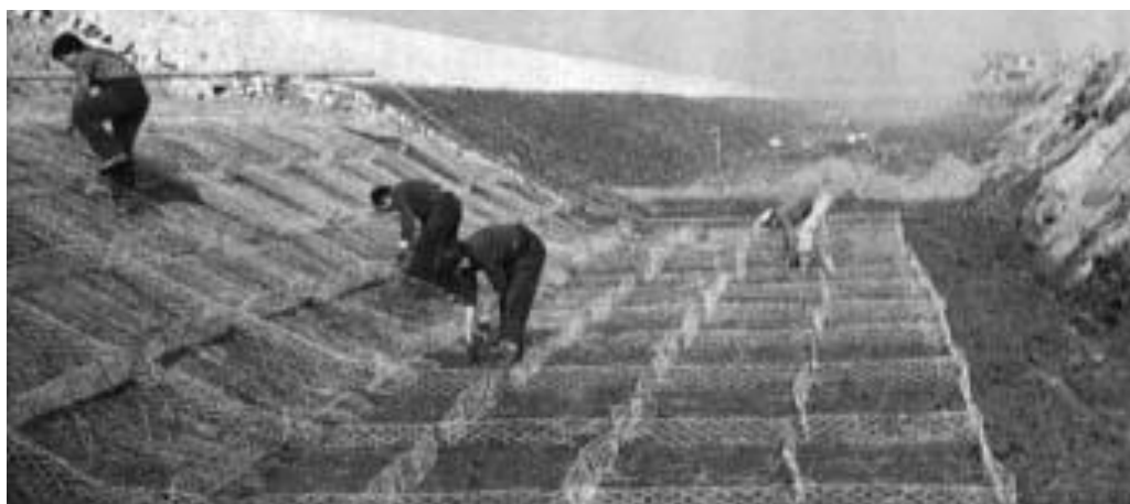
Figura 21 - Proceso de llenado de colchonetas
