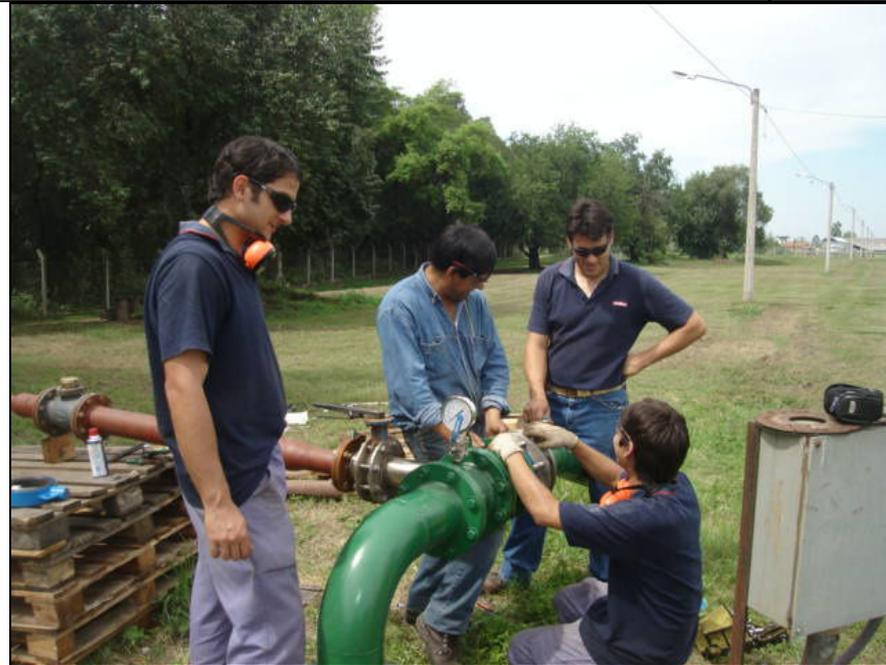
**Figura N° 28:** Equipo Sumergible de Bombeo Nuevo con Cable de Vaina Plana
