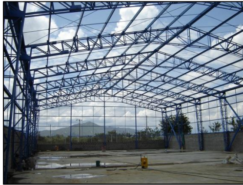
Figura 10.3 – Estructuras metálicas con acero para techo.
