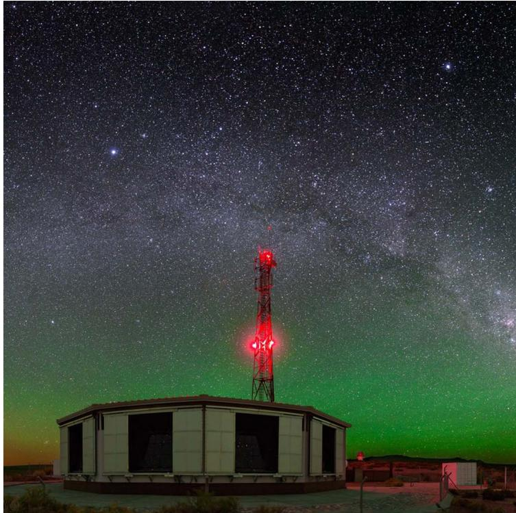
FIGURA 2.3: Edificio de fluorescencia "Los Morados". En su interior se encuentran seis telescopios cubriendo un campo de observación que va de  $\sim 1,7^\circ$  hasta  $\sim 30,3^\circ$  en elevación y  $180^\circ$  en azimut.
