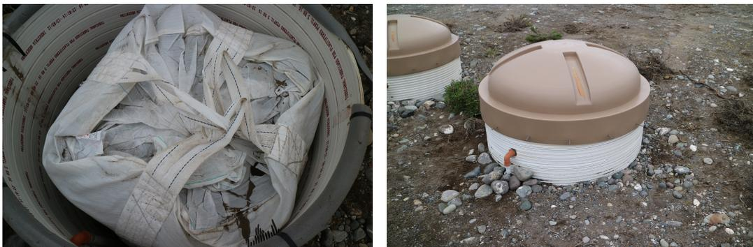
FIGURA 7.4: La fotografía de la izquierda muestra el rellenado del tubo de acceso con las bolsas de tierra. La fotografía de la derecha muestra el tubo de acceso con su tapa exterior.
