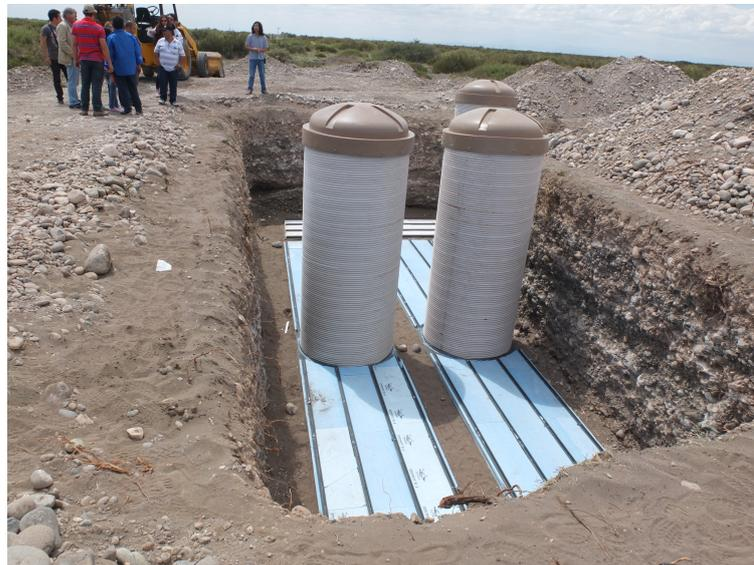
FIGURA 2.7: Instalación de tres módulos contadores de muones en una posición del *infill*. Se puede observar en el centro de cada módulo el tubo de acceso a la electrónica.
