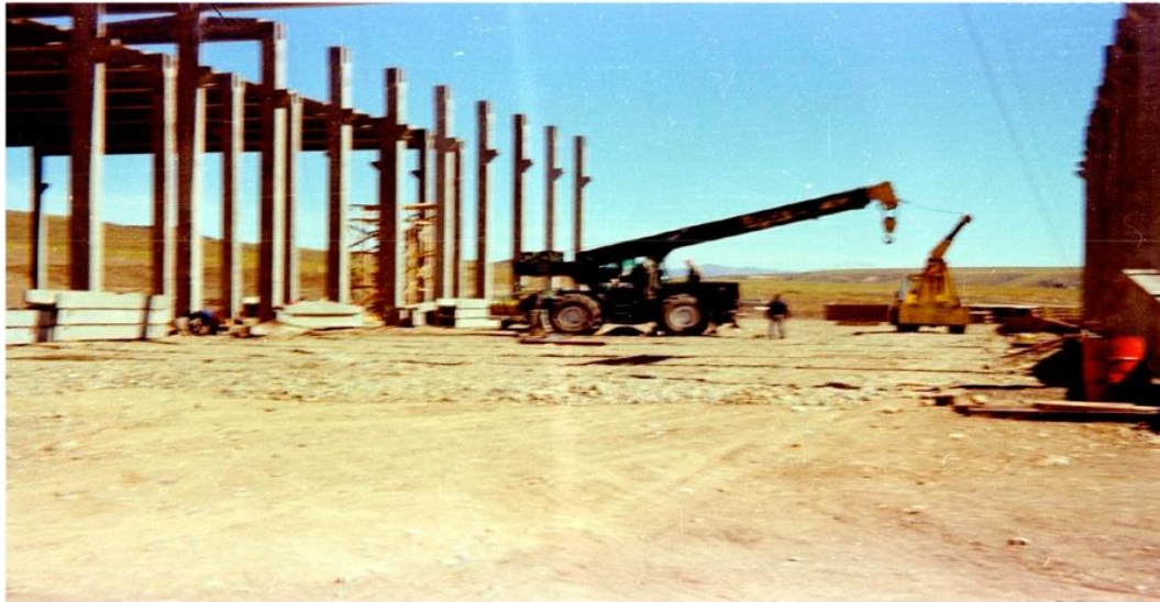
Figura 4: Obra civil A1, año 1981
