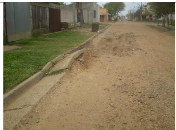
Foto 2.28 - Tramo de cordón cuneta a reconstruir
