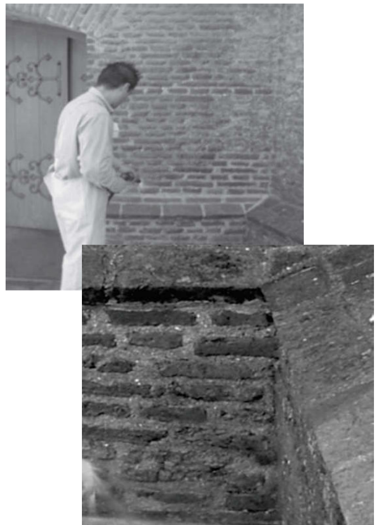
Figura 10. Proceso de Hidrolavado
