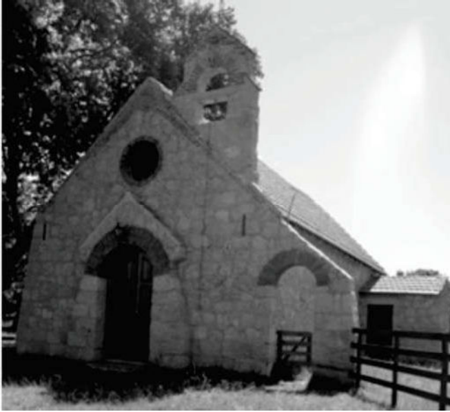
Figura 13. Vista de la Capilla en Colonia San Anselmo, Entre Ríos.
