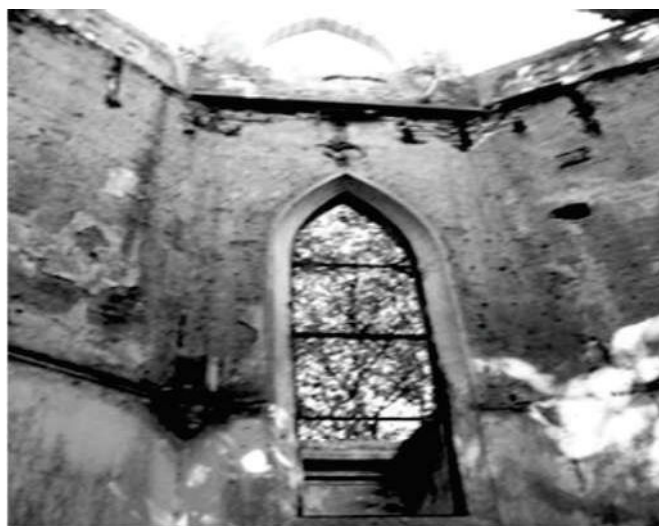
Figura 31. Detalle de la iglesia en ruinas, Localidad M. Fernandez
