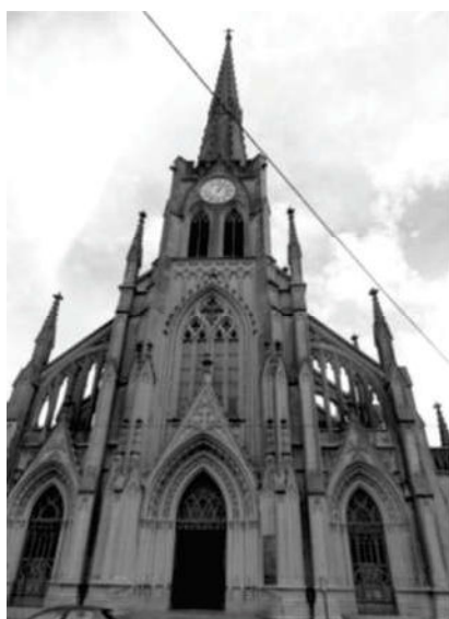
Figura 23. Vista de la iglesia actual.
