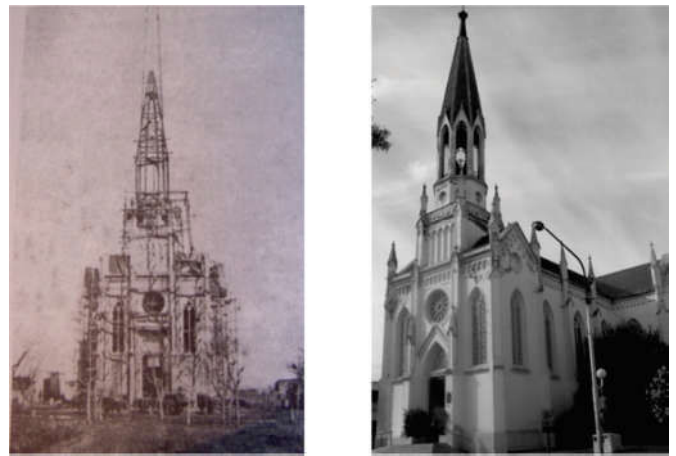
Figura 22. Vista de la iglesia Inmaculada Concepción durante la construcción y actual. Se observa la perfilaría metálica empleada en la torre campanario.
