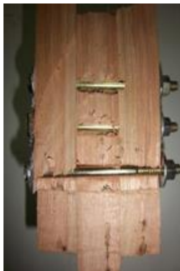
Figura 4.16 Cuerpo de prueba abierto después de ser ensayado.
