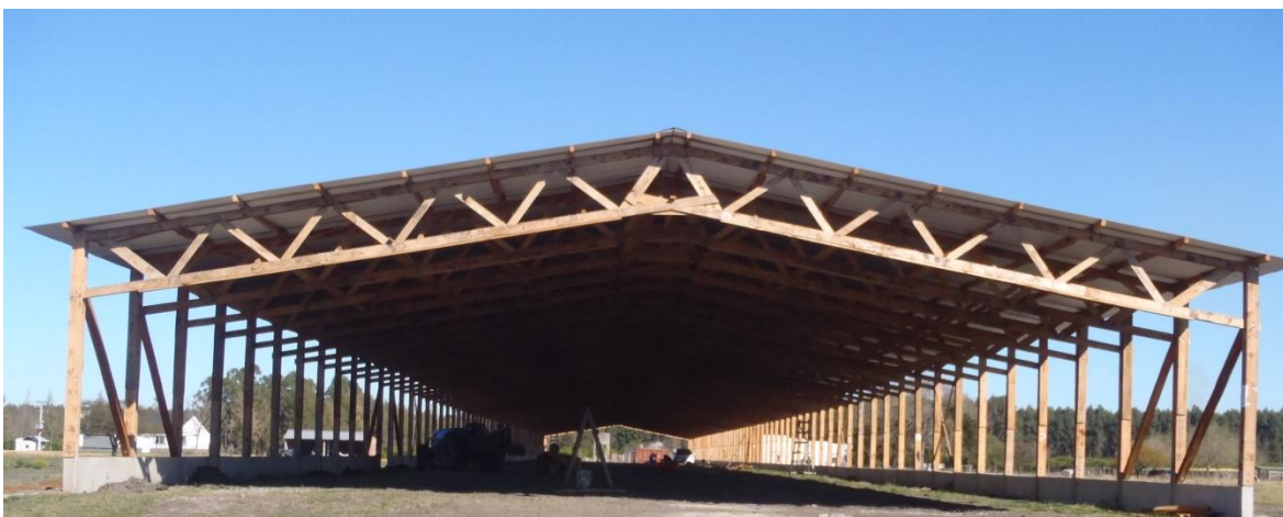
Figura 4.24 Estructura reticulada de 16m de luz de cálculo, construida con madera de Eucalyptus grandis y conexiones ejecutadas con clavos de pequeño diámetro.
