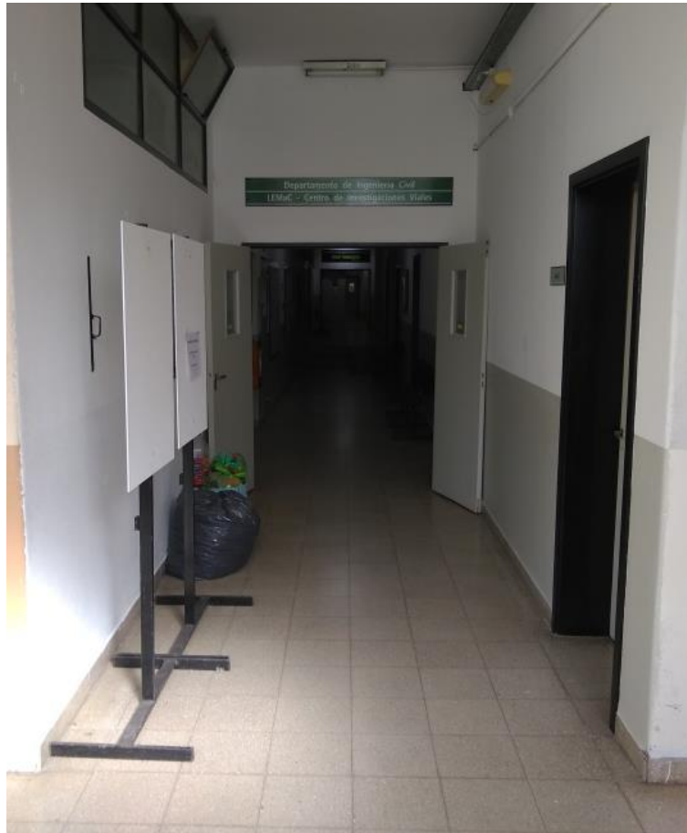
2º Pasillo dependiente del Departamento de Civil
