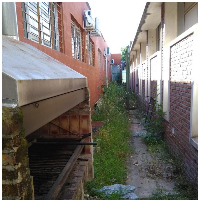
Pasillo exterior entre pasillos de civil y 1º
