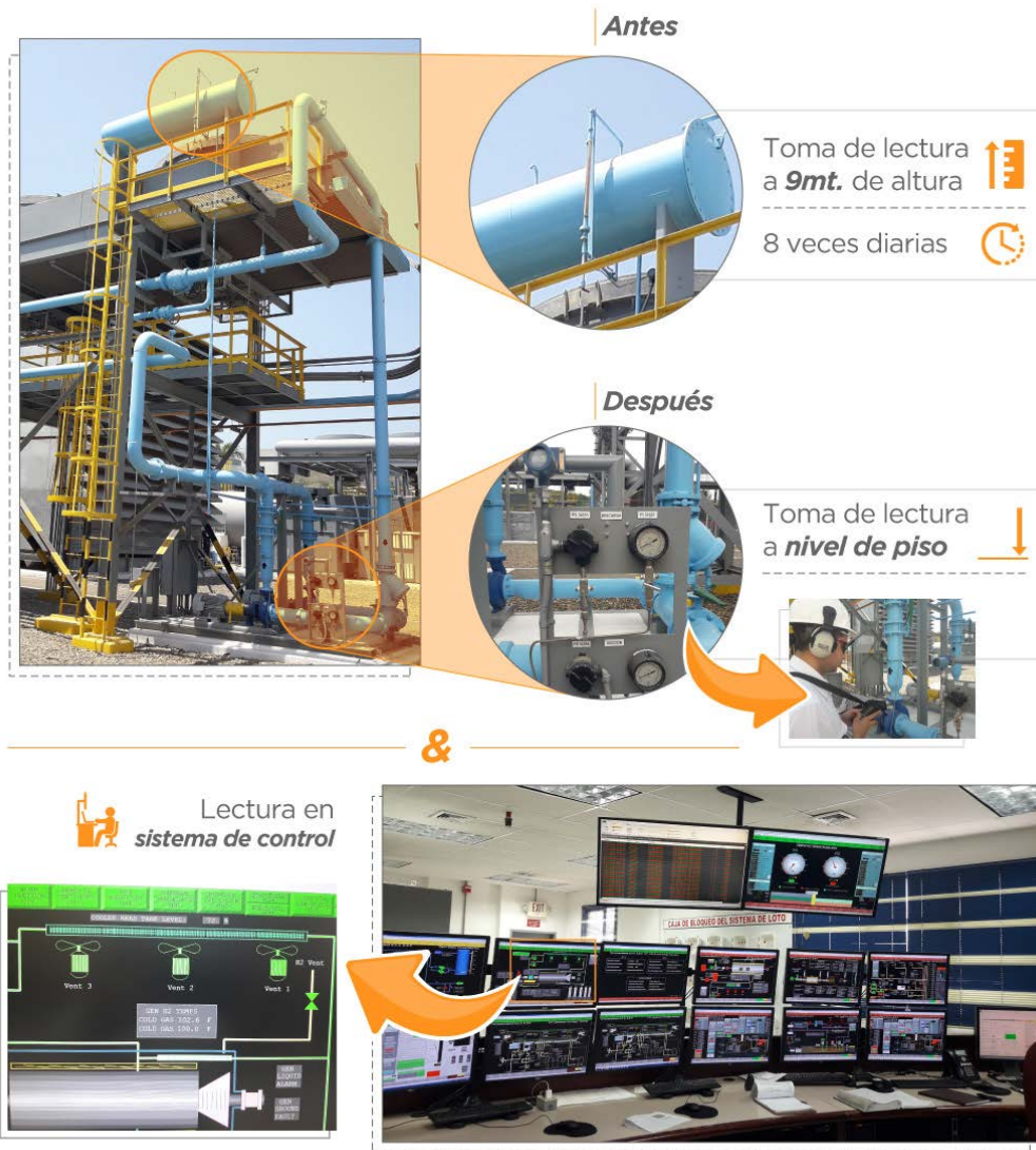
Ilustración 9 Instalación de controles de ingeniería
