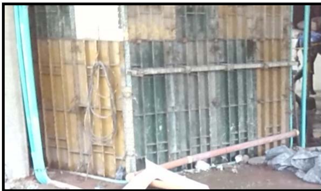
Ilustración 10 Cabina instalada en proyecto, vista 2
