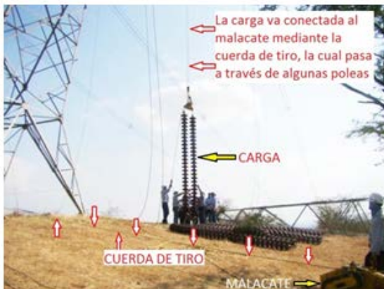
Figura 2. Conexión malacate - carga
