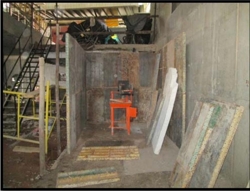
Ilustración 4 Armado de muros cabina aislación ruido 1
