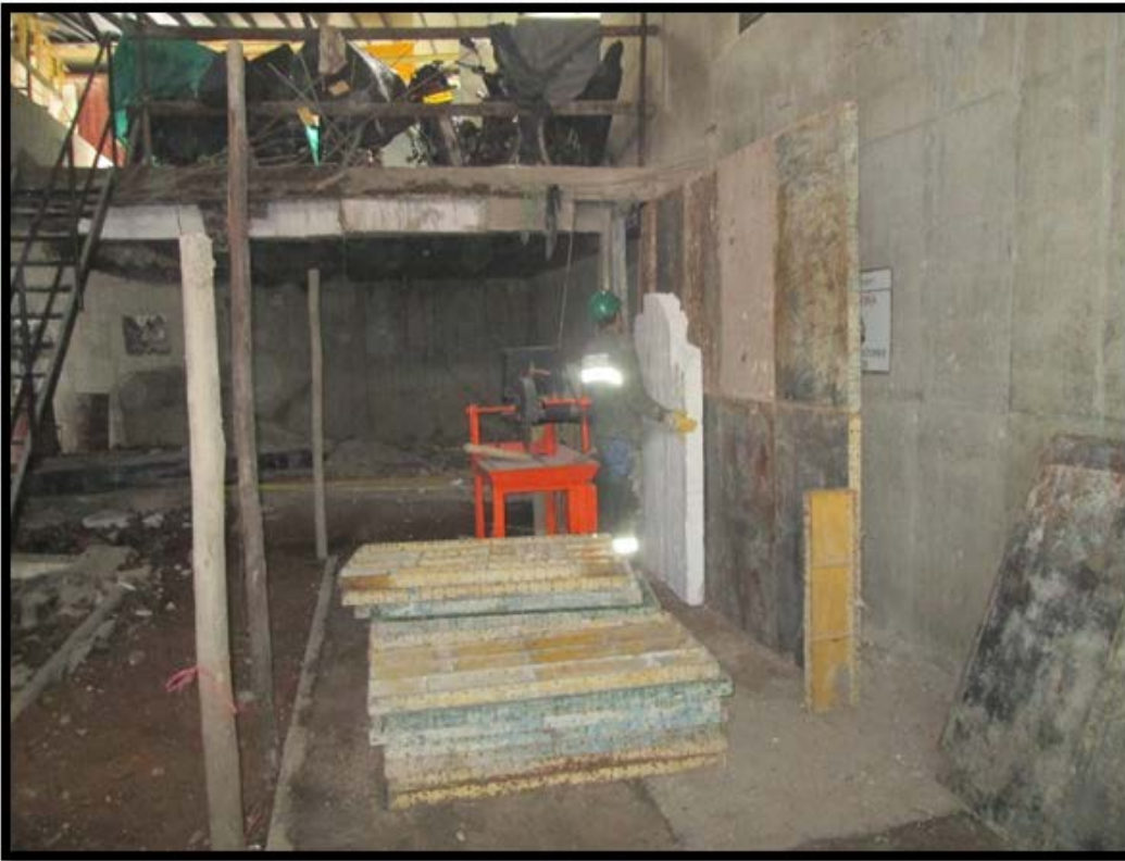
Ilustración 8 Instalación de Icopor en interior de cabina
