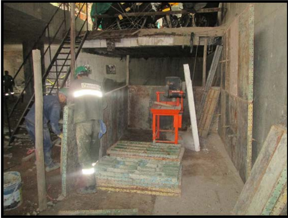
Ilustración 5 Armado de muros cabina aislación ruido 2
