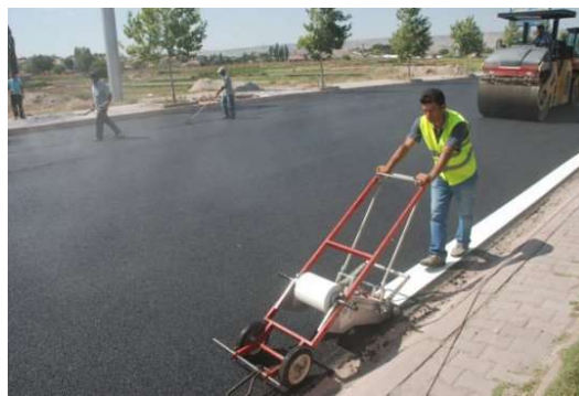
Imagen 8: Terminación superficie pavimentada con SMA en Alemania
