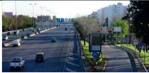
Imagen 7: Autopista Richieri: SMA en Argentina
