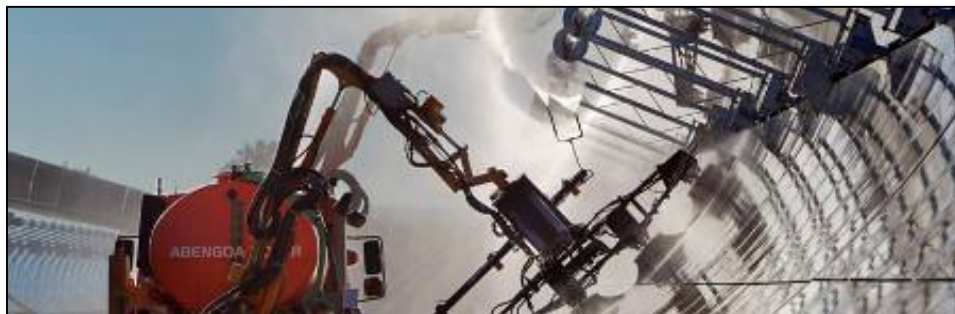
Ilustración 37. Limpieza de heliostatos, llevado a cabo por Abengoa Solar
