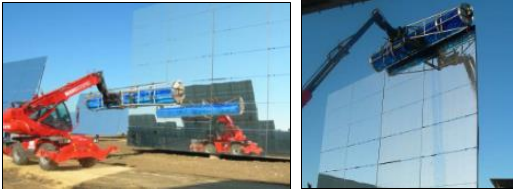
Ilustración 40. Limpieza de heliostatos
