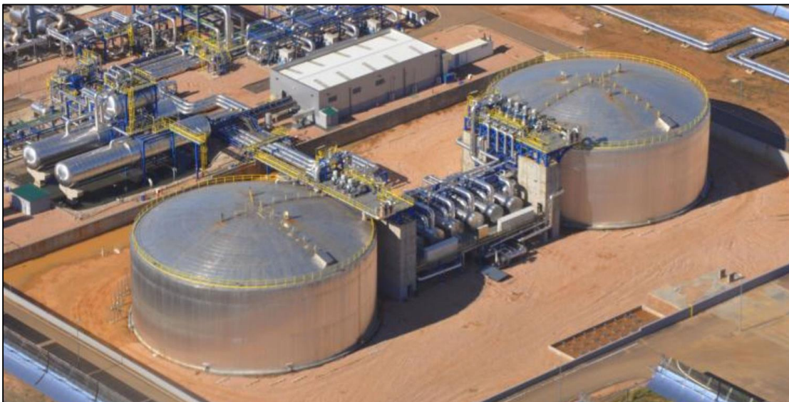
Ilustración 9. Imagen real de tanques de almacenamiento de sales fundidas
