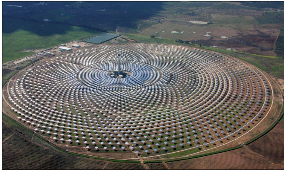
Ilustración 1. Central Gemasolar de Sevilla
