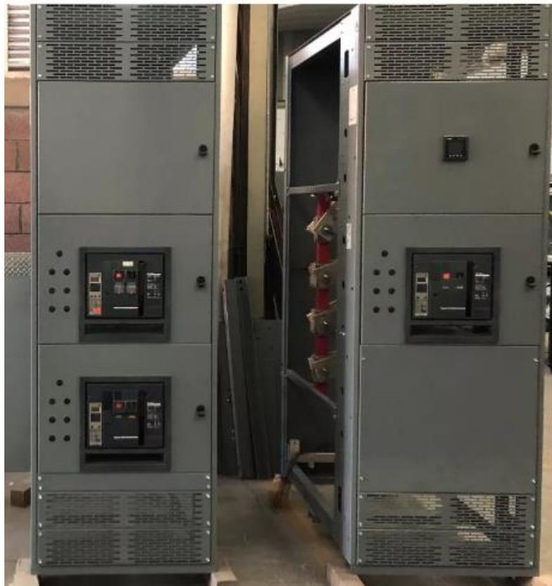
Interenclavamiento por cables de tres interruptores automáticos Masterpact NW (alternativa I)
