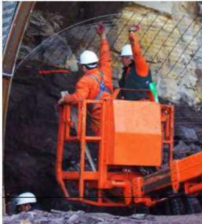
**Imagen 23** Colocación de mallas electro soldadas - Obra RN N°75 La Rioja
