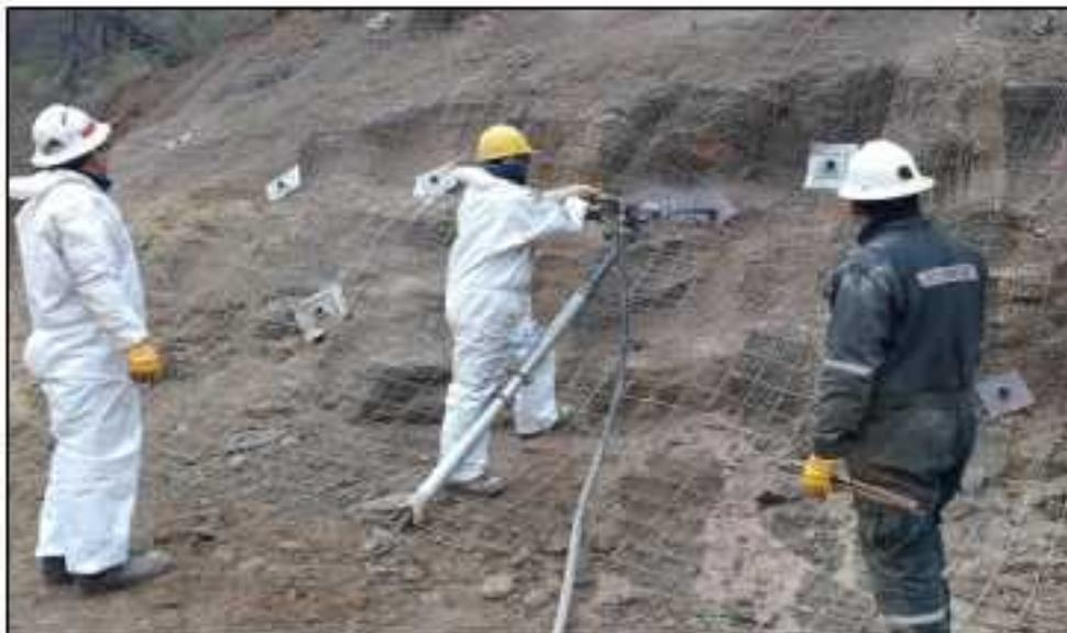
Imagen 8 Perforación manual con martillo - Obra RN N°75 La Rioja
