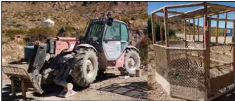
**Imagen 20**Equipo de elevación y jaula de protección para saneo manual- obra RN N°75 La Rioja
