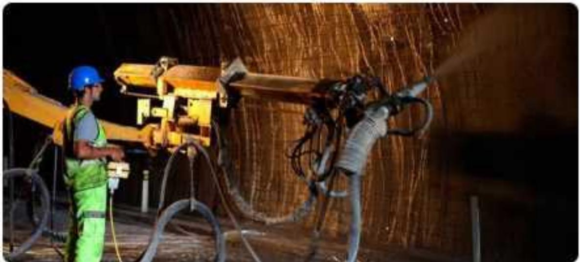
Imagen 24 Fortificación con hormigón proyectado – extracción Manual para la PRL OSALAN
