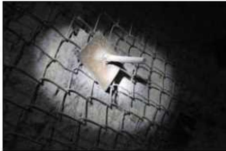
**Imagen 22** Sostenimiento flexible - Manual para la PRL OSALAN
