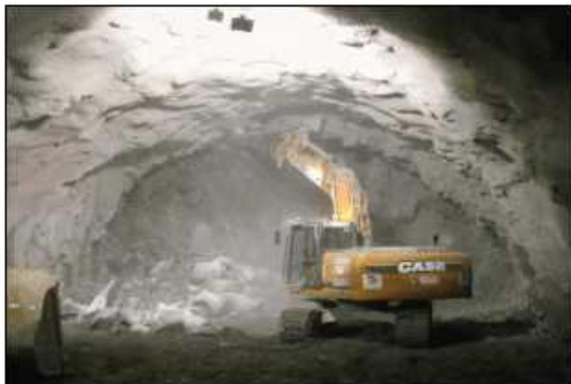
**Imagen 18** Saneo mecánico-extracción Manual para la PRL OSALAN
