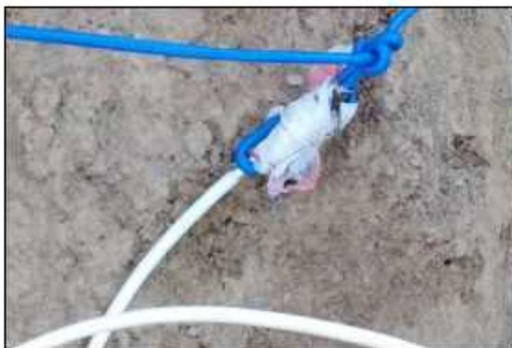
**Imagen 13** Cordón detonante amarrado a la mecha de encendido - obra RN N°75 La Rioja
