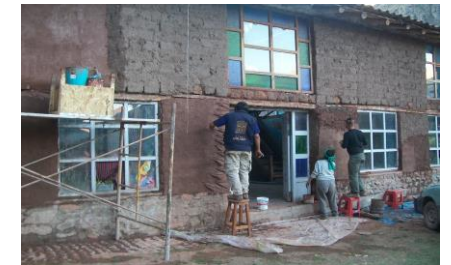
Figura 12. Realizando el revoque nuevo, Hacienda Logde la Paukartica, Cuzco, Perú. Foto: Arturo Ruf Caballero.
