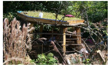
Figura 18. Construcción casita ed niños, Samaipata, Bolivia. Foto: Antonio Mariano Moretti.
