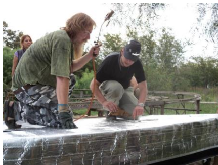
Figura 37. Techos verdes, Navarro, Argentina. Foto: Carlos Placitelli.
