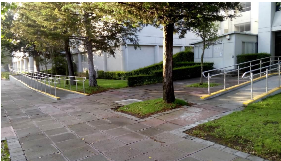
Figura 7 Continuidad de rampas, interrumpida por un árbol justo en medio del trayecto, Tecnológico de Monterrey, México (Solano, 2018)
