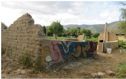
Figura 16. Construcción del gallinero, Cochabamba, Bolivia. Foto: Antonio Mariano Moretti.
