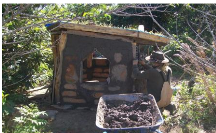
Figura 19. Construcción casita ed niños, Samaipata, Bolivia. Foto: Antonio Mariano Moretti.
