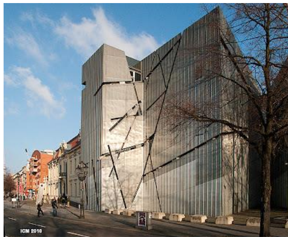
Figura 14. La estética plantea como elemento de innovación el acceso del edificio del Museo Judío de Berlín (deconstructivista) a través del edificio contiguo del S. XVIII, lo que no respeta la lógica natural que cada edificio tenga su propio acceso, creando confusión en el usuario (Tomado de https://www.archdaily.mx/mx/772830/clasicos-de-arquitectura-museo-judio-berlin-daniel-libeskind )
