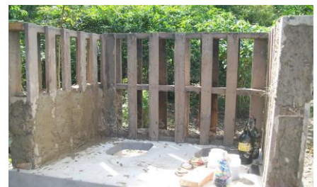
Figura 21. Construcción baños secos, Samaipata, Bolivia. Foto: Antonio Mariano Moretti.
