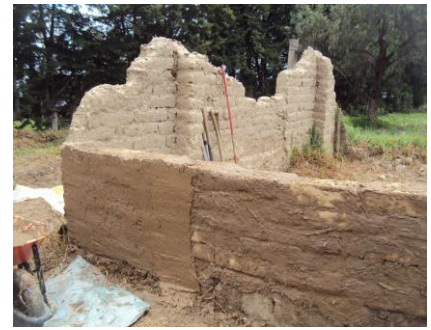
Figura 15. Construcción del gallinero, Cochabamba, Bolivia. Foto: Antonio Mariano Moretti.
