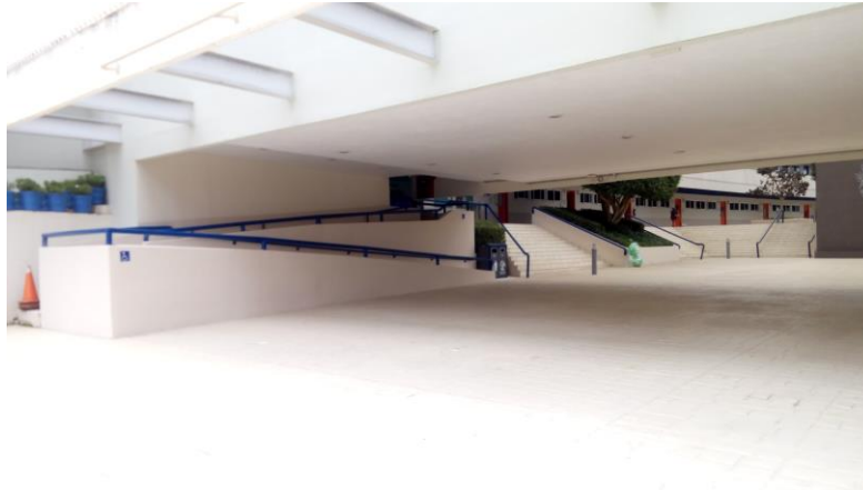
Figura 9. Remiendos en la arquitectura: rampas para “parchar” la falta de simplicidad en los desplazamientos verticales (Solano 2018)
