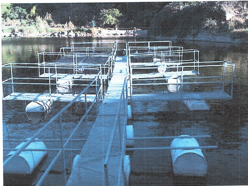
Fig. 7: Pasillo que une a seis compartimentos que posee la jaula
