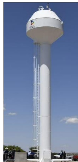
Imagen 33 - Tanque elevado de agua potable
