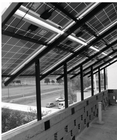
Fig. 3: Vista de la estructura portante de los paneles.
