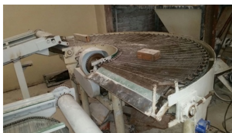
F 3.5 Cinta de enfriamiento Fuente: Foto Propia
