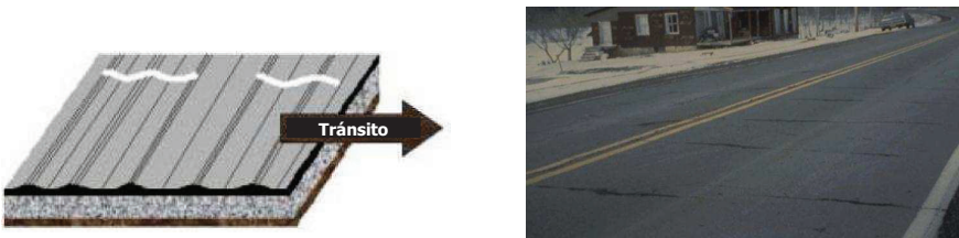
Figura 7 Falla del tipo corrugación
