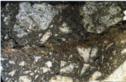
Figura 29 Interfase mezcla asfáltica + emulsión + material FM PP + emulsión + mezcla asfáltica
