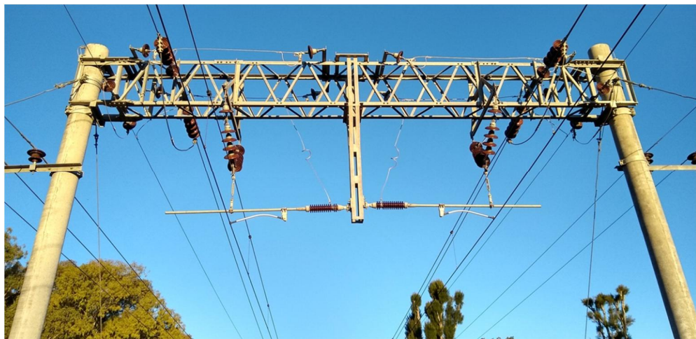
Postes de centro de cantón, con retención.
