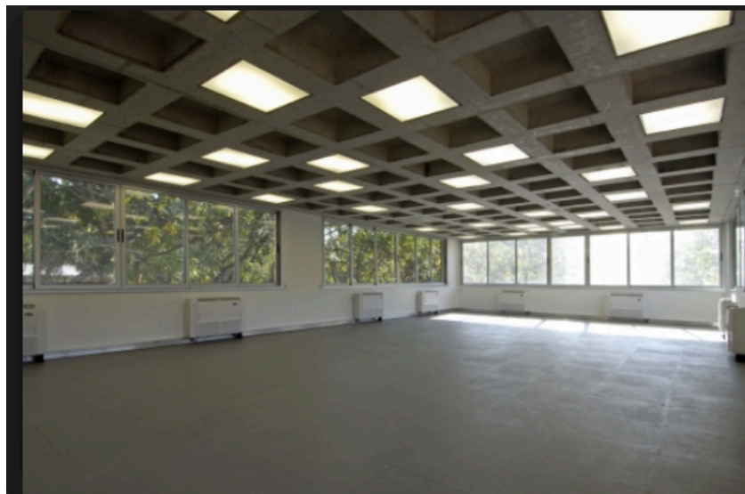
Figura 18: Entrepisos sin vigas con losas casetonadas
