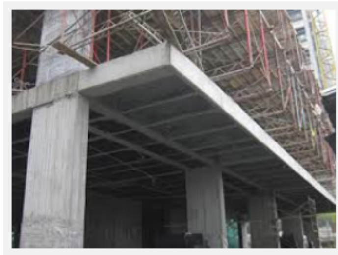
Figura 19: Entrepisos sin vigas la losa es un placa casetonada
