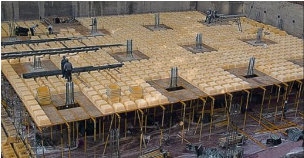
Figura 29: Casetones recuperables para losas a la vista
