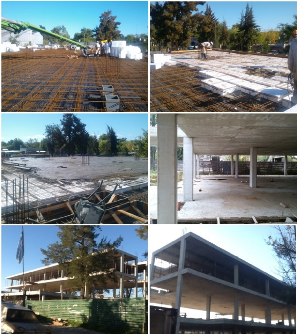
Figura 42: Losa alivianada en Nordelta
