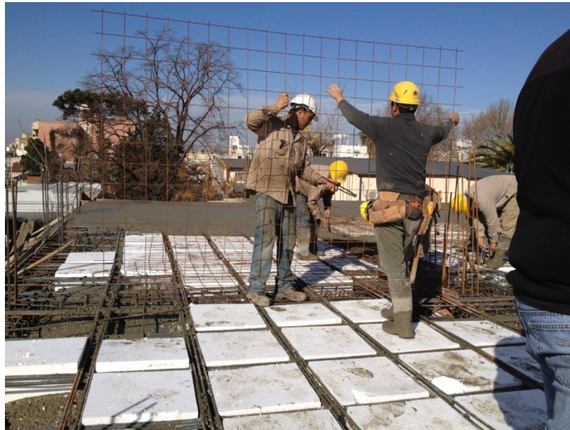
Figura 35: Montado de mallas superiores
