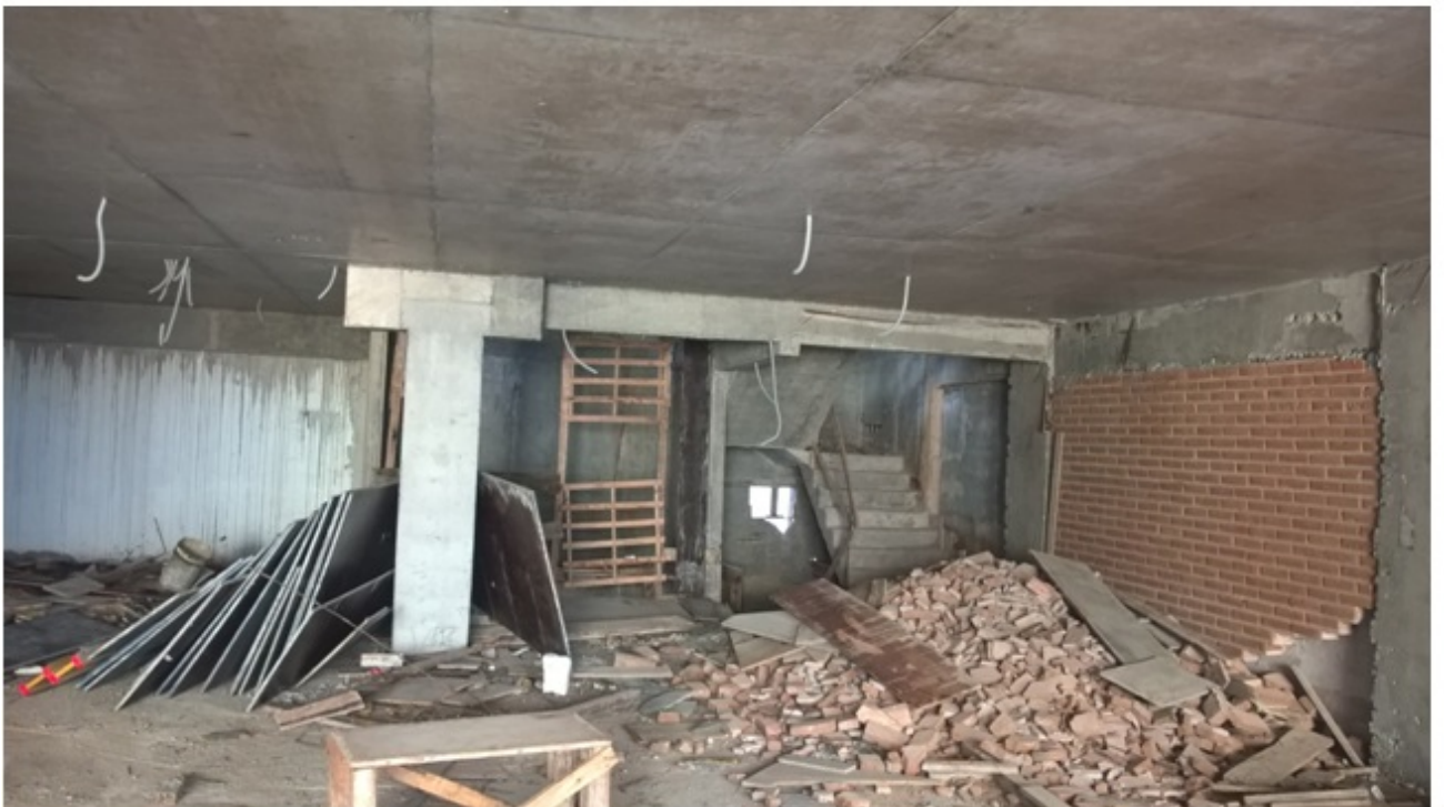
Figura 44: Losa alivianada en edificio multifamiliar
