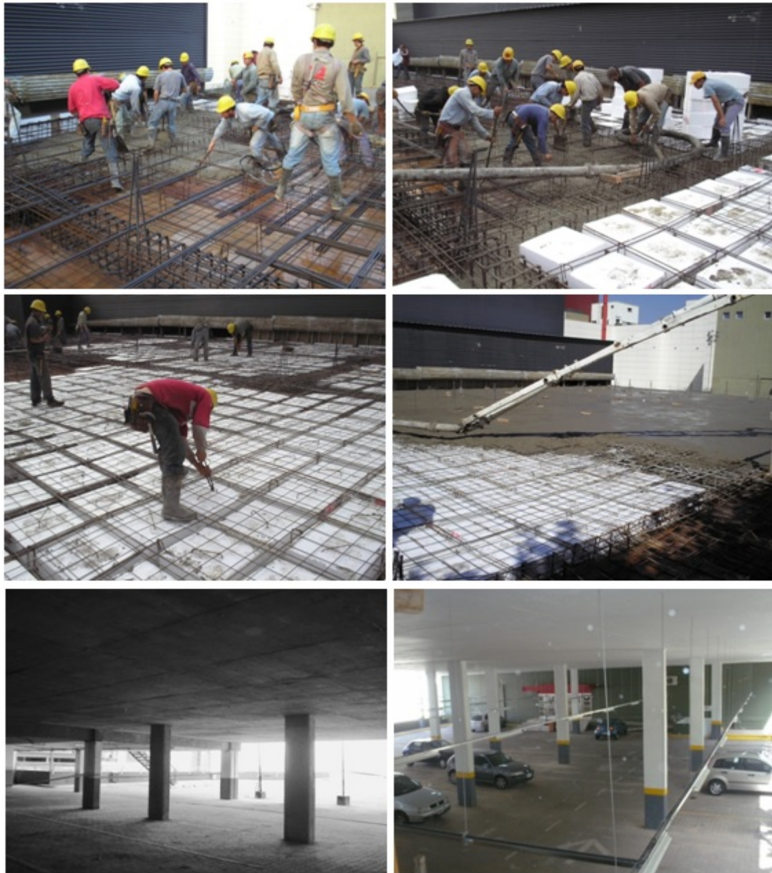
Figura 39: Etapas de ejecución y vistas terminadas en Shopping Devoto
