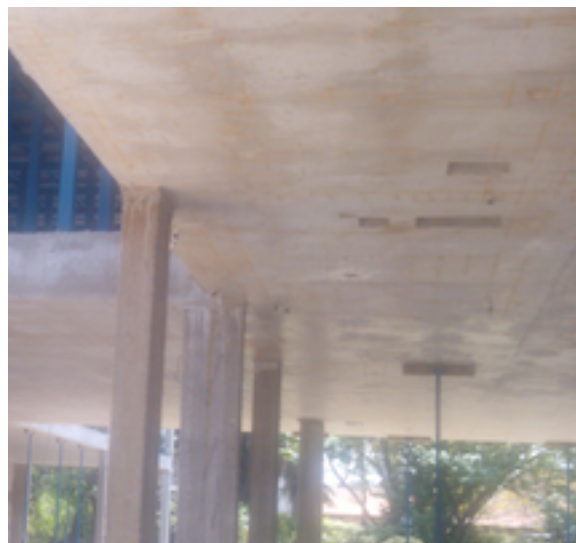
Figura 28: Losa con abaco y alivianamiento cubierto
