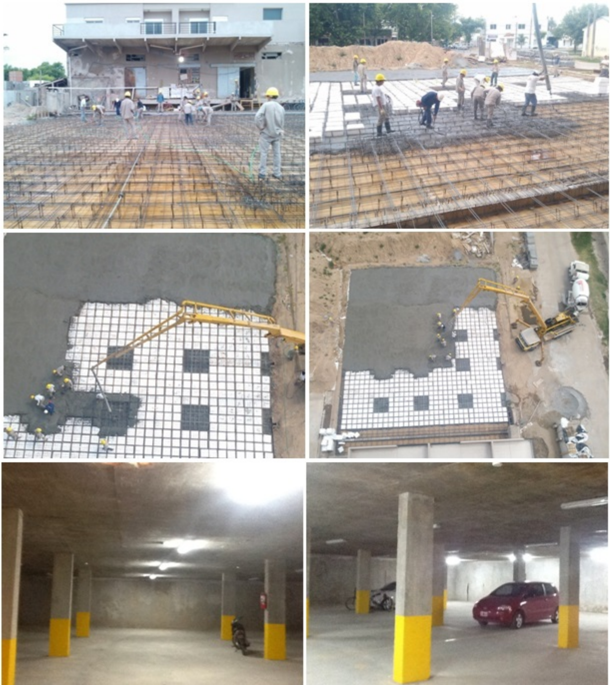
Figura 45: Losa alivianada en cochera Marcos Juárez
