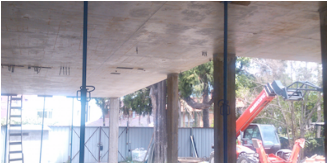
Figura 27: Losa con abaco y alivianamiento cubierto
