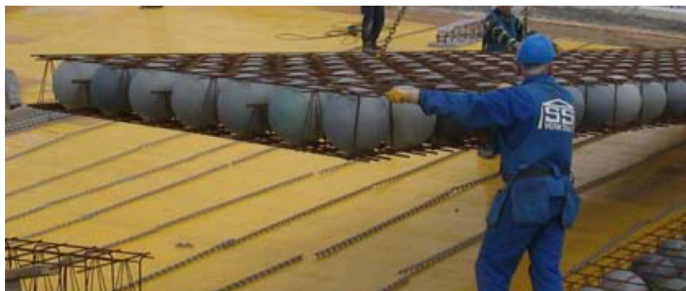
Figura 54: Forma de montaje del sistema BubbleDeck
