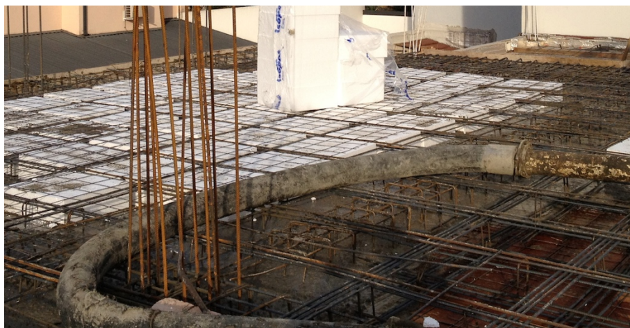
Figura 34: Colocación de bloques etapa inicial
