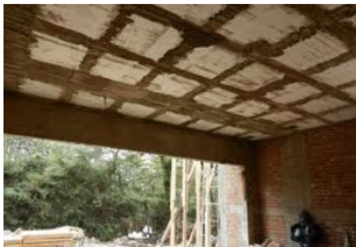
Figura 19: Entrepisos sin vigas la losa es un placa casetonada
