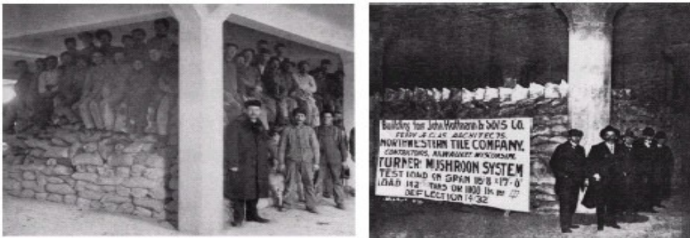
Figura 6: Pruebas de cargas de entrepisos sin vigas en América
