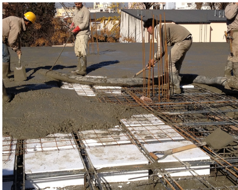
Figura 36: Completado de tareas de llenado
