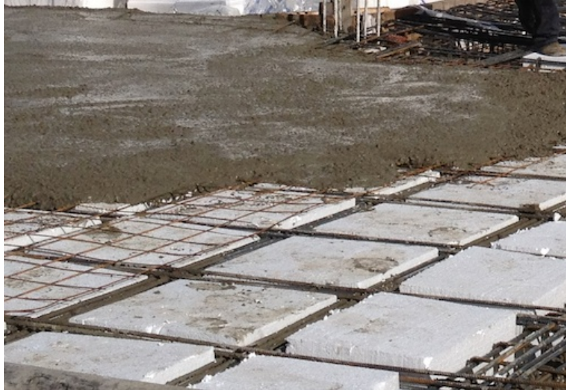
Figura 37: Avance de la terminacion de llenado de la seccion
