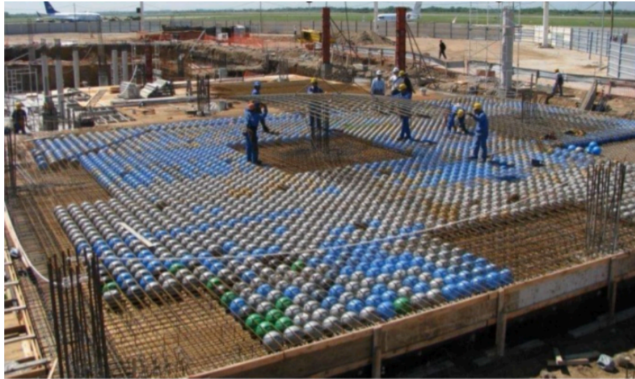
Figura 50: Disposicion de las esferan que alivianan el alma de la placa
