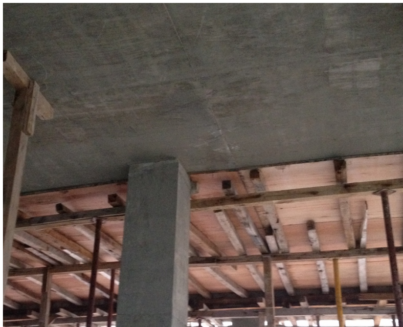
Figura 38: Vista inferior luego de desencofrar
