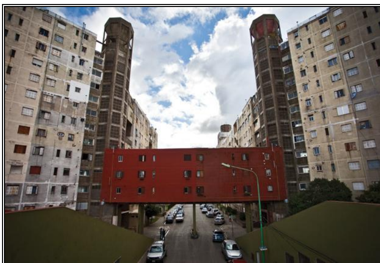
Figura 4. Complejo Piedrabuena puentes.
