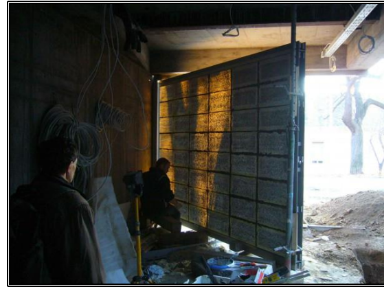
Figura 22. Concreto Traslucido.
