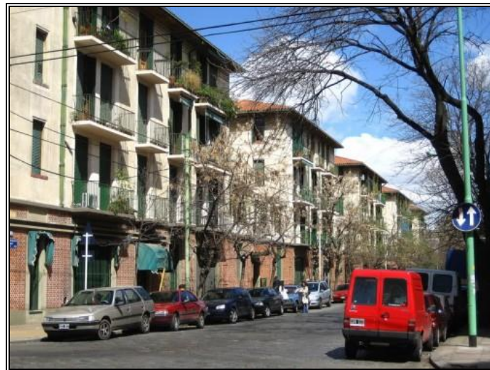
Figura 11. Conjunto Los Andes - vista desde la calle Concepción Arenal.
