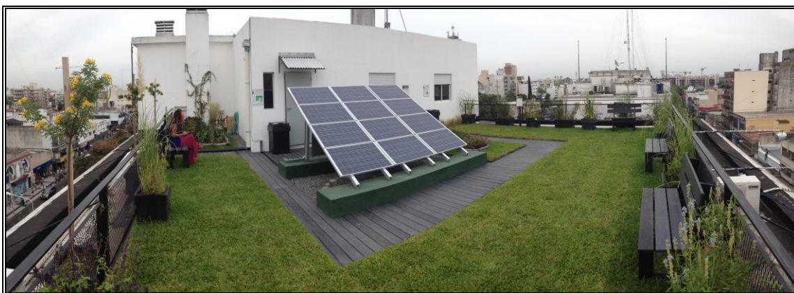
Figura 65. Terrazas Verdes con paneles fotovoltaicos 62 .
