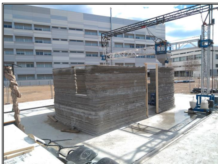
Figura 25. Vivienda ejecutada con impresora 3D en Valencia. Empresa Be More 3D 28 .
