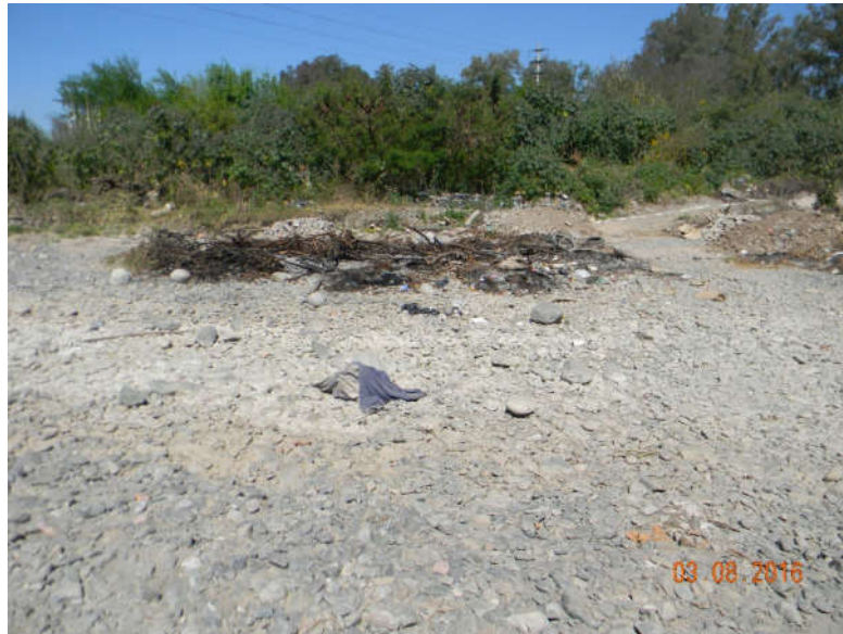
Foto 35: Vaciado de residuos dentro del cauce del río Lules
