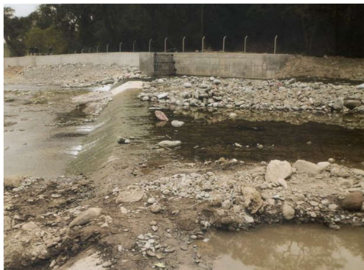
Foto 1: Azud Nivelador sobre el Río Lules para derivar a Toma 2 (Extraída de: La cuenca del Río Lules2011-El sistema de riego)
