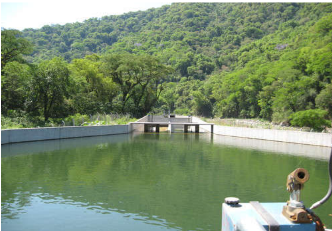
Foto 3: Desarenador de la Toma 2 (Extraída de PROSAP –Desarrollo de área Agrícola)
