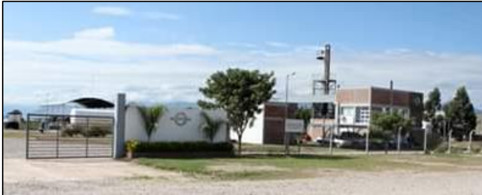
Figura 3.7: Imagen de la Planta de Salta Petrol.
