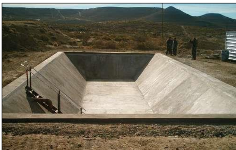
Figura 4.18: Imagen de una pileta API para la decantación de lodos separación de agua.
