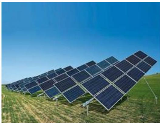
*Figura 18, Seguidor solar de un eje polar.*
