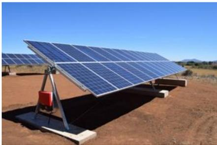
*Seguidor Solar de 1 eje Horizontal DEGERtracker S60H-PF, <https://degeriberica.com/articulo-tecnico-viabilidad-de-la-instalacion-de-seguidores>*
