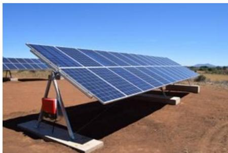
*Figura 20, Seguidor solar de eje horizontal.*
