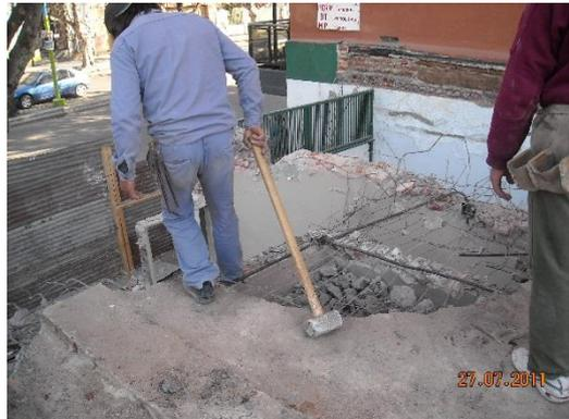
Fotografía 4-6. Demolición manual
