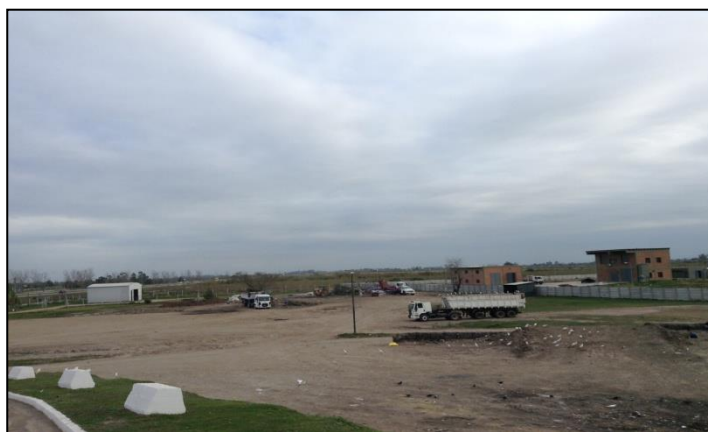
Figura 11: Playa de descarga para recuperación de residuos y galpón de acopio de materiales en Planta de Transferencia San Felipe. Fuente: elaboración propia, 2014.
