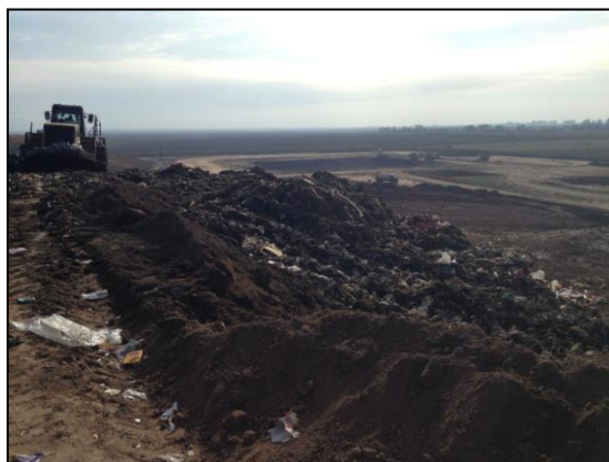
Figura 13: Construcción de nuevo módulo en Overo Pozo. Fuente: elaboración propia, 2014.
