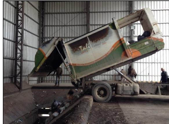
Figura 10: Tolva de Descarga de Planta de Transferencia de San Felipe. Fuente: elaboración propia, 2014.
