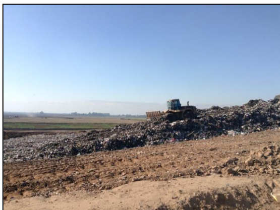
Figura 12: Módulo en operación en Overo Pozo. Fuente: elaboración propia, 2014.
