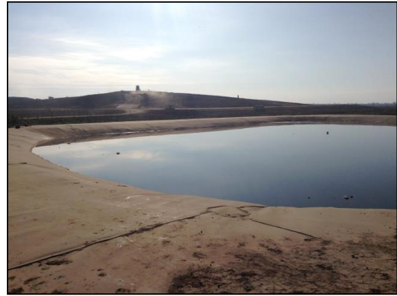
Figura 15: Pileta de Almacenamiento de líquidos lixiviados. Fuente: elaboración propia, 2014.
